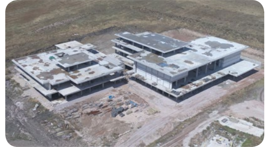
YENİ MERKEZ YERLEŞKE PROJESİ - ÖĞRENCİ YAŞAM MERKEZİ İNŞAATI
