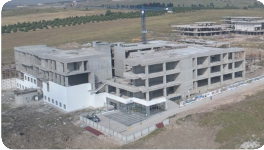
YENİ MERKEZ YERLEŞKE PROJESİ - MERKEZİ DERSLİK İNŞAATI
