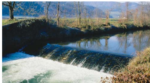
Sinoidalschwelle (Sonderform einer Sohlschwelle) bei Fkm 6,25.
