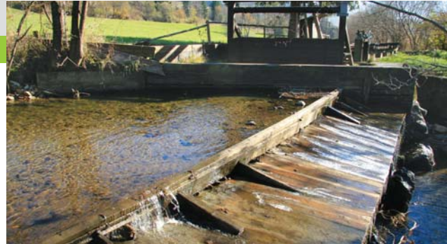
Weinbergerwehr Reichenfels, Beispiel für eine Querverbauung und Kontinuumsunterbrechung an der Lavant.
