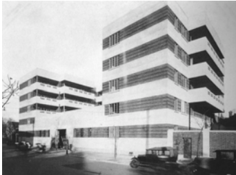
Polizeistation in der Chengdu Road wurde in den dreißiger Jahren vom SMC gebaut. Der Wechsel der Fassadenmaterialien Putz und Klinker sowie die Struktur verweisen auf das Victoria Nurse Home . Abb. Birnie Danzker (2005: 346)
