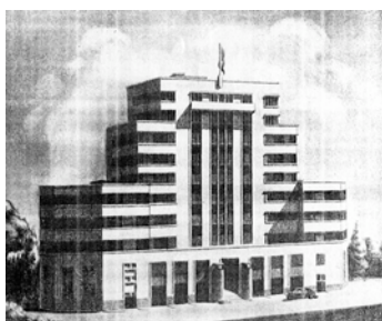
Die Polizeistation der Architekten Leonard, Vesserey und Kruze in der Französischen Konzession ist deutlich vom Art Deco geprägt. Abb. The Builder 1/35: 11
