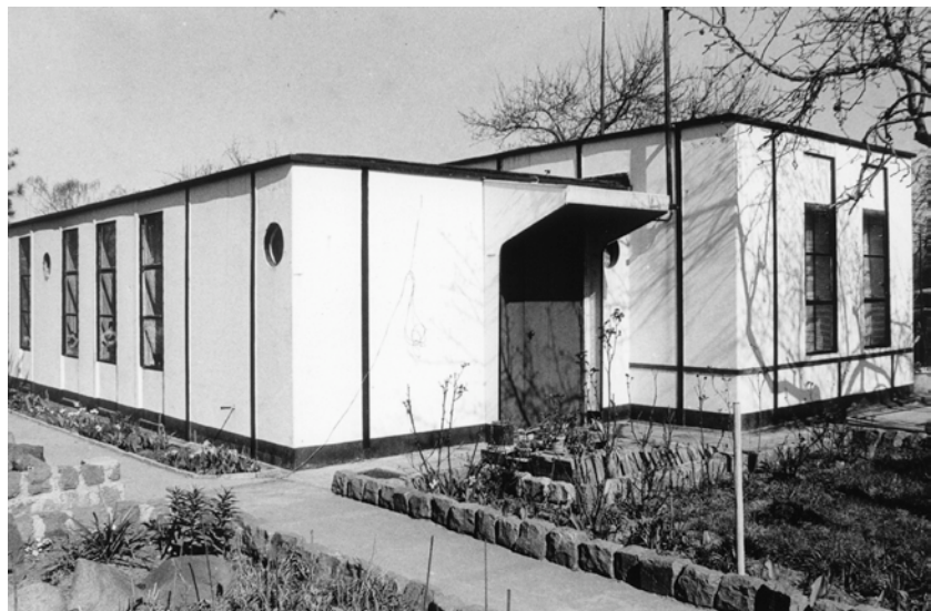
Das Stahlhaus in Dessau kurz nach der Sanierung von 1976. Abb. NL RP, PA GP
