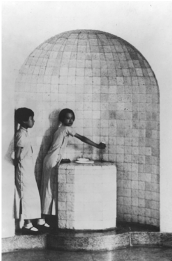
Trinkbrunnen in einer Nische im Flur vor den Klassenräumen. Abb. NL RH, PA MH
