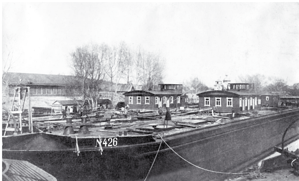
Строительство палубных барж
