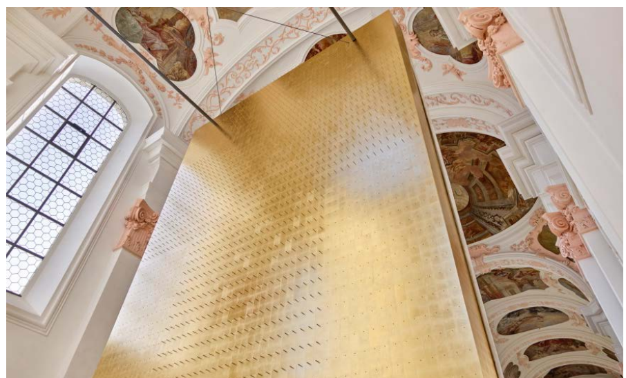
Die teilweise auskragenden Befestigungspunkte der goldfarbenen Metallschindeln auf der Rückwand des Monumentalgemäldes formen ein überdimensionales Kreuz. (Foto © Marcel Peda)
