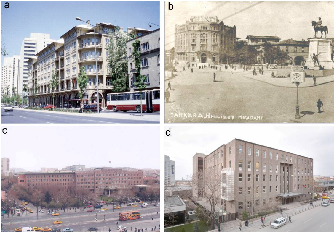
Şekil 11. a) 2. Vakıf Apartmanı, 1928-1930, Mimar Kemaleddin Bey. b) Türkiye İs Bankası, 1929, Giulio Mongeri. c) Dil ve Tarih, Coğrafya Fakültesi, 1937-1939, Bruno Taut. d) Merkez Bankası, 1931-1935, Clemens Holzmeister.
