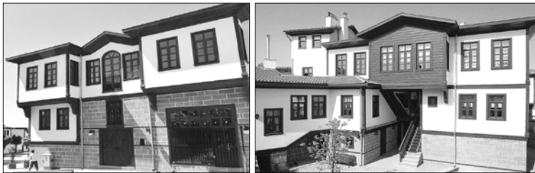
Foto 4. Rekonstrüksiyon sonrası Kamil Paşa Konağı'nın (meydan) cephesi ve avlusu
