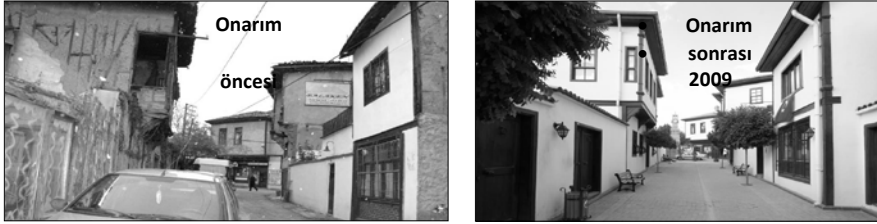
Foto 2. Dutlu Sokak cephe onarımı öncesi ve sonrası
