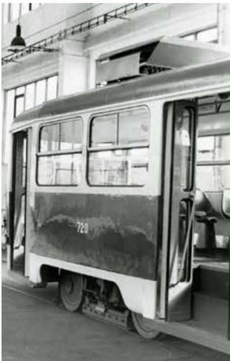
Na voze č. 720 bylo v říjnu roku 1980 užito nové řešení krytí odporníku na střeše vozidla pomocí zlepšováku „SUDORI“, jenž vyvinuli pracovníci DP. Ten byl později namontován také na další vozy, které opustili dílny po GO před vozem ev. č. 720 a stal se charakteristickým znakem ostravských vozů T3M. (foto: Jindřich Sulek)
