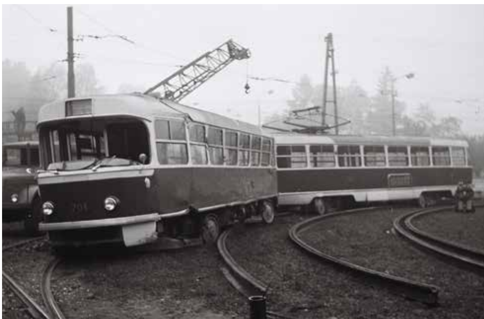
Tramvaj T3 ev. č. 701 byla v porovnání s ostatními „té trojkami“ z první série zařazena později. Na fotografii vidíme „dvojče“ 701+702 po nehodě na původní smyčce Vřesinská (Poruba, smyčka), při níž došlo na voze ev. č. 701 k poškození levé bočnice, která se po převrnutí na bok odrazila od naskládaných kolejnic, jež jsou na snímku rovněž velmi dobře patrné. (foto: Ing. Rudolf Pavelek)
