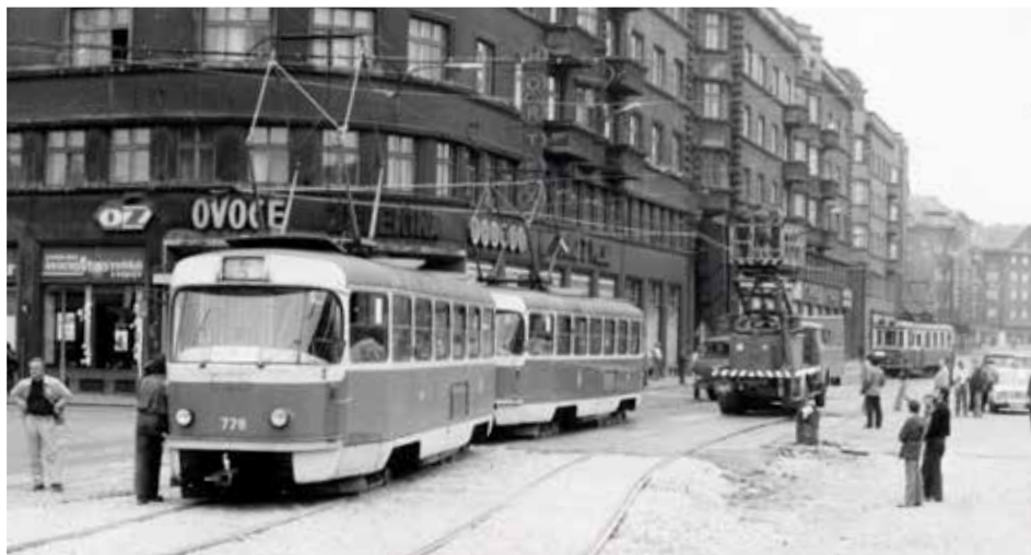
Vůz ev. č. 778 jako první projel dne 13. 9. 1981 přeložkou tramvajové trati při stavbě nových Frýdlantských mostů. V rohové budově se dnes nachází sídlo ostravského DP. (foto: Ing. Rudolf Pavelek)
