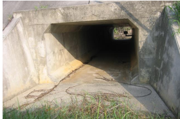
道路構造の改良：幹線道路へのアンダーパスの設置 (写真：自然環境研究センター)
