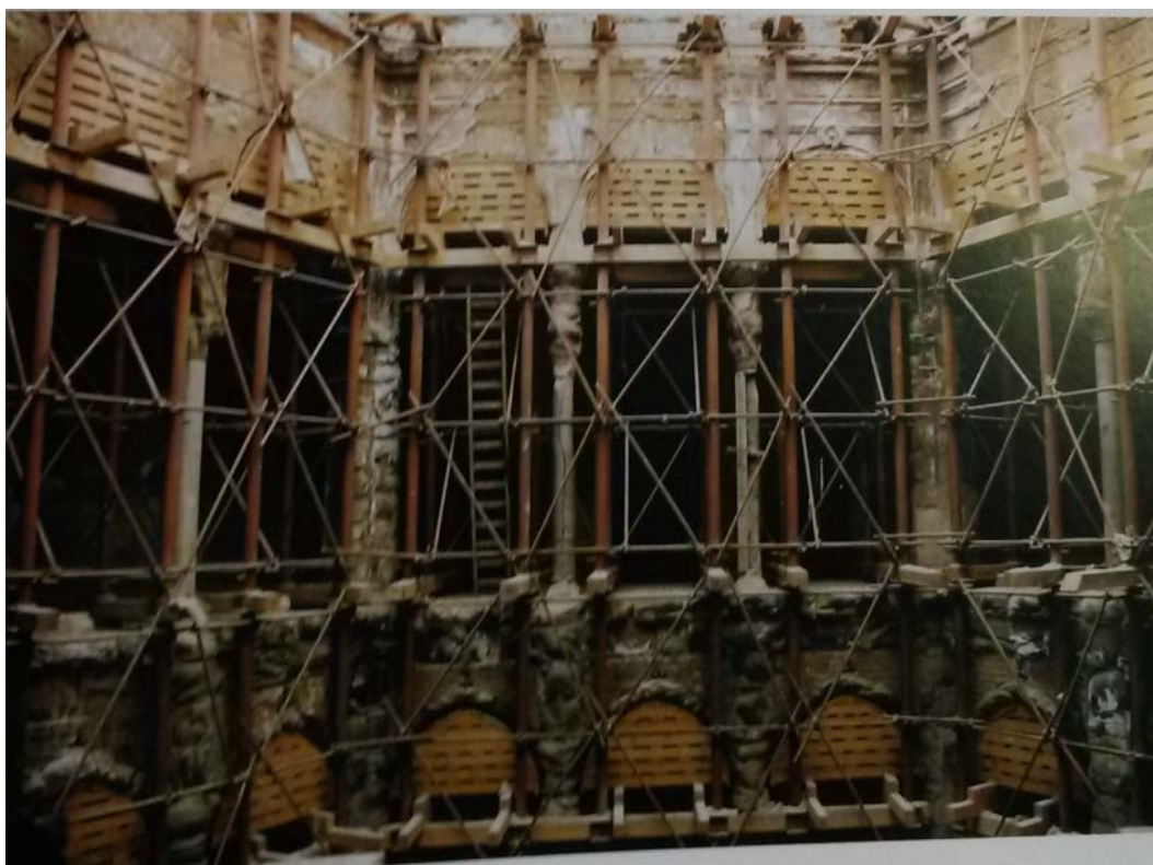
Slika 11. – Obnova Vijećnice – konstruktivni radovi
