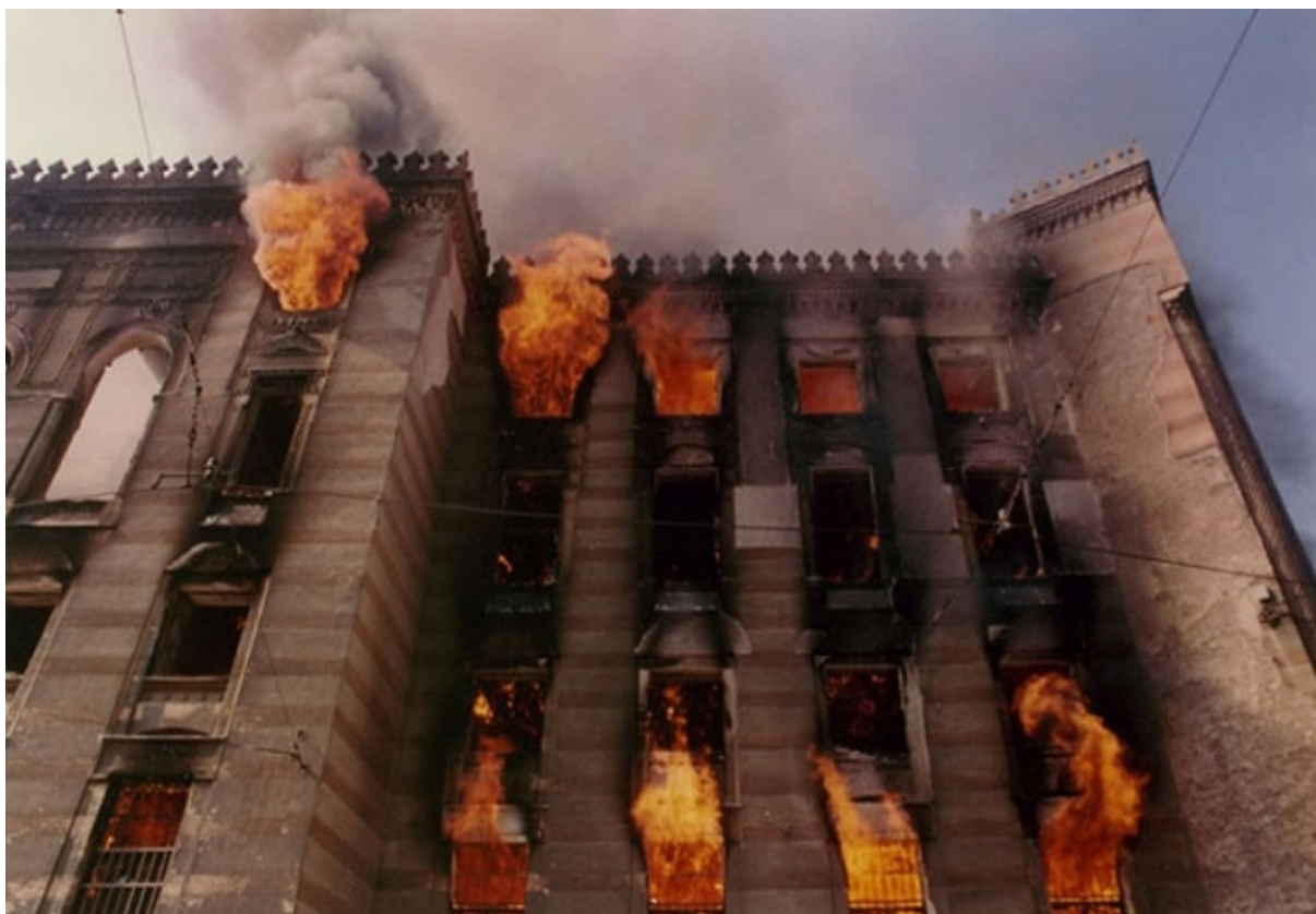
Slika 14. Zgrada Vijećnice u plamenu
