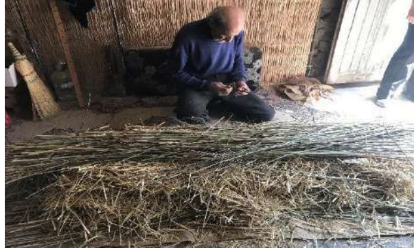
Fotoğraf 16. Kamış ve hışırın yerleştirilmesi (Kılıç Karatay, 2019)
