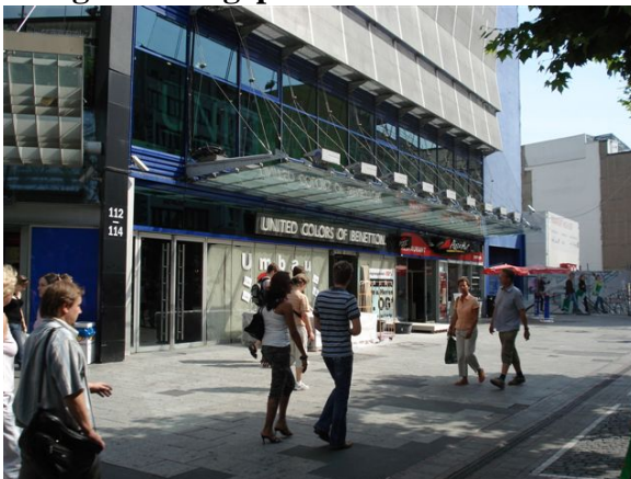
Zeilgalerie Fassade Zeil
