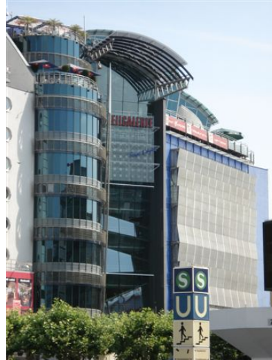
Zeilgalerie Fassade Zeil
