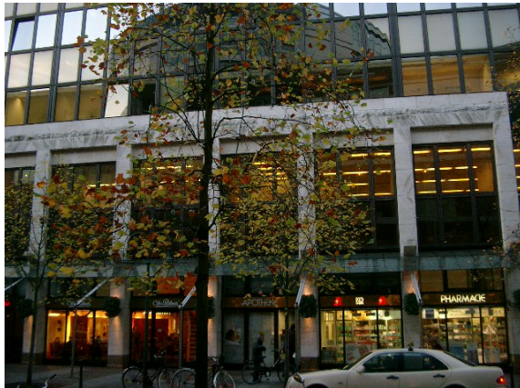
Kö Galerie Fassade Grünstrasse
