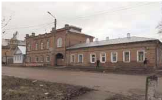
Одноэтажный жилой пристрой (д. 24)
