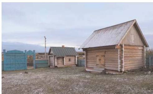
Надворные постройки (воссозданы)
