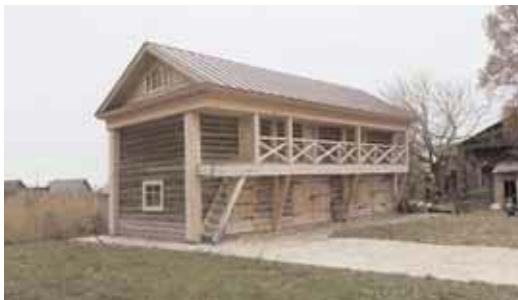
Хозяйственная постройка (восстановление)
