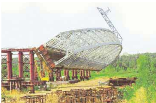
Снятие последней подлинной мостовой фермы
