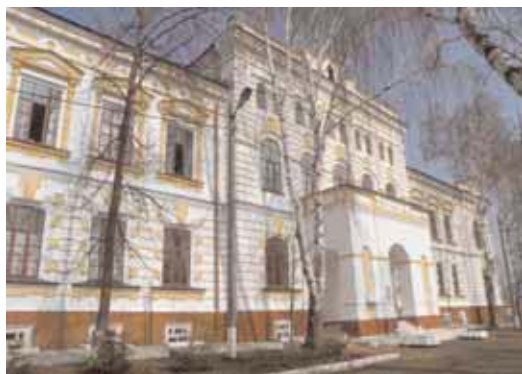
Фасад по ул. Набережная
