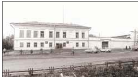
Дом Батолина. Вид с ул. Толстого. Фото до 1999 г.
