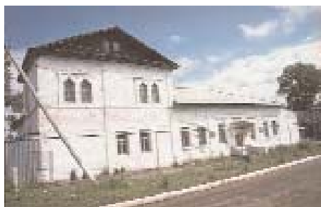
Здание мужского училища до реконструкции
