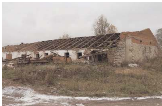
Момент разборки здания конезавода. Октябрь 2015 г.
