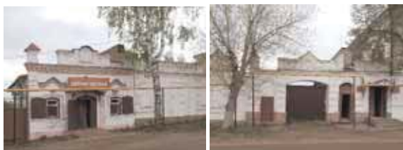
Магазин и хозяйственная постройка при усадьбе П.И. Колсанова
