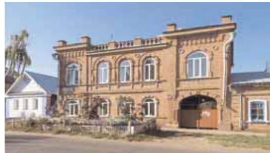
Двухэтажный учебный корпус (д. 26)
