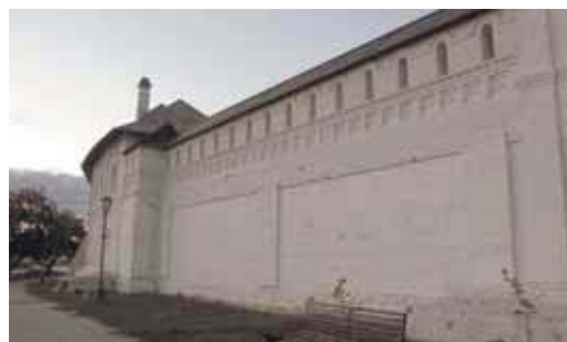
Крытый переход по стене
