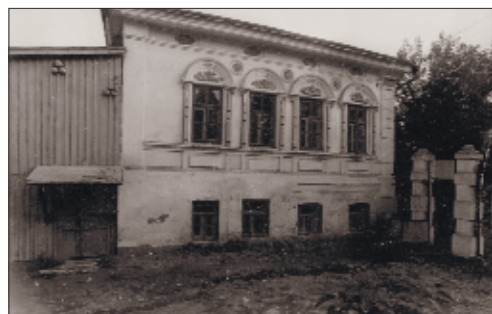
Торец дома и пилоны капитки. Фото до 1997 г.
