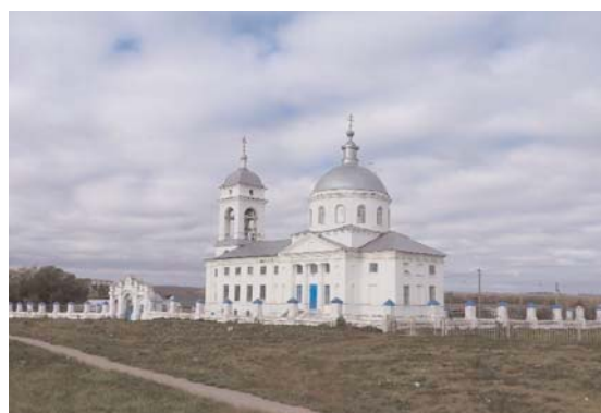
Вид с северо-запада.
