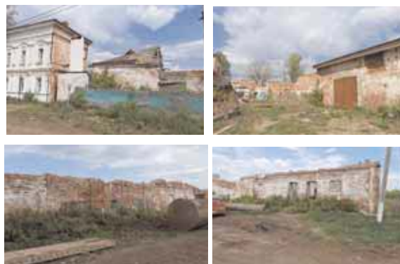
Заброшенные производственные корпуса и часть ограды
