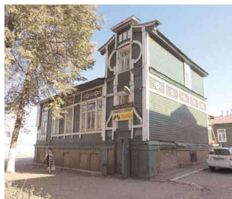
Фасад по ул. Джалиля
