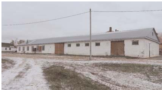
Кирпичная конюшня, 1890 г.
