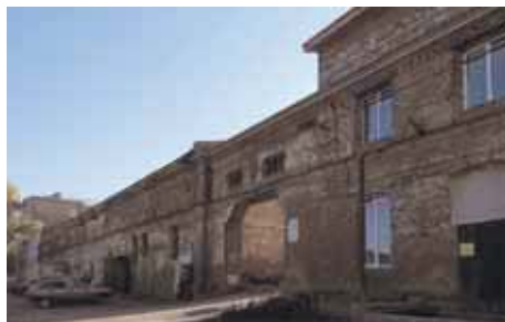
Стена и корпус по ул. К. Либкнехта
