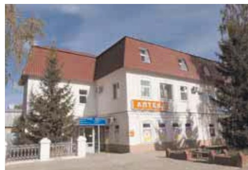
Здание магазина и склада (N 27)
