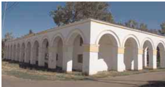
Вид с северо-запада
