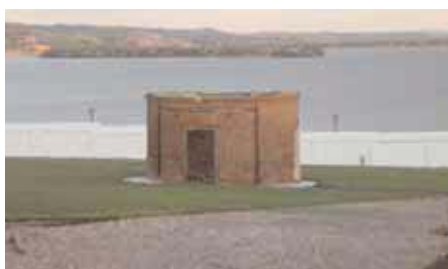
Кирпичное основание водонапорной башни
