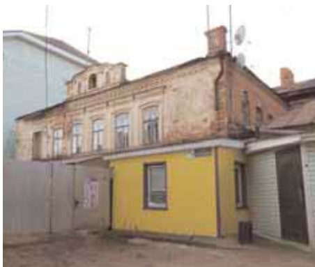
Флигель в глубине участка (по ул. Толстого)
