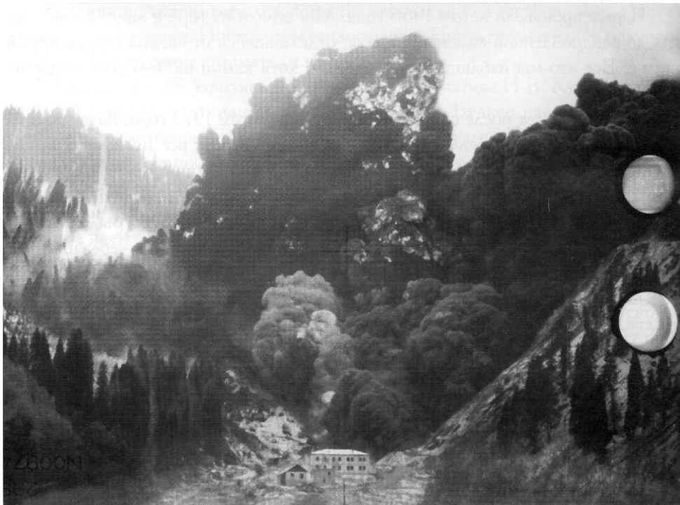
Момент направленного взрыва, создавшего противоселевую плотину на реке Малая Алмаатинка, в урочище Медео, в 15 км от Алма-Аты. 1966 г.
