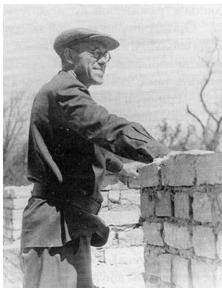
Первые опыты строительства в поселке Феофания под Киевом. 1945 г.
