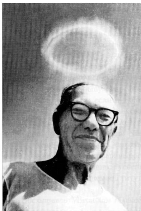
Академик М.А. Лаврентьев не был святым — это в небо поднялось вихревое кольцо, образованное подрывом 3 т бензина, распыленного в воздухе.
