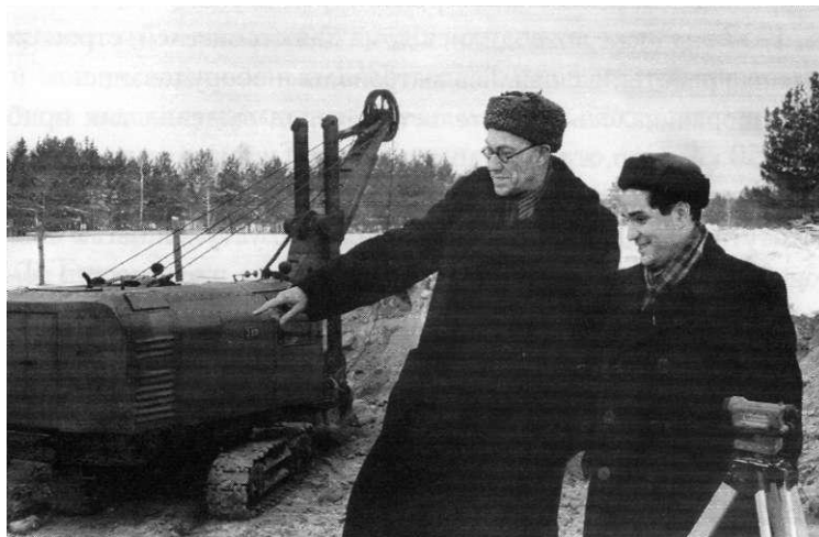
М.А. Лаврентьев и П.П. Белинский у котлована будущего здания Института гидродинамики. Осень 1957 г.
