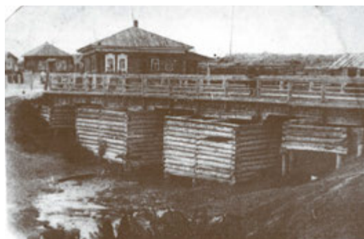
Мост через р. Иня
