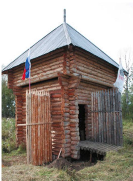
Воссозданная башня острога
