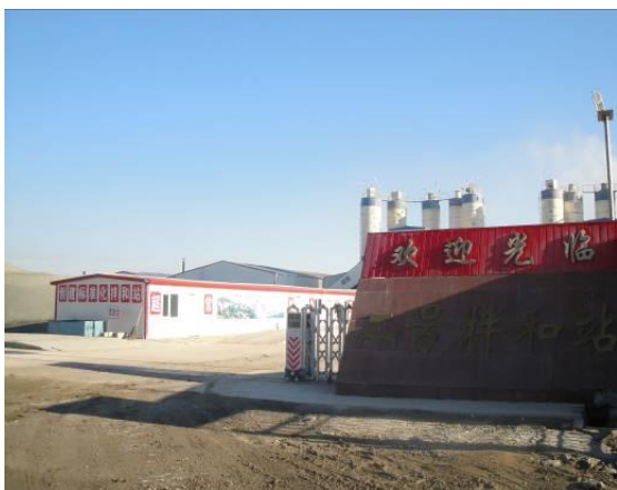
客运专线典型拌合站
