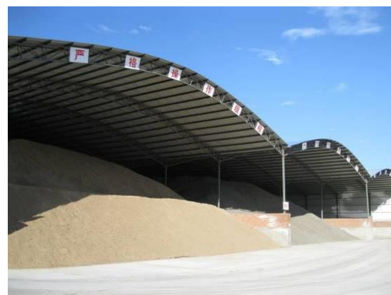
拌合站中砂、碎石密闭存放
