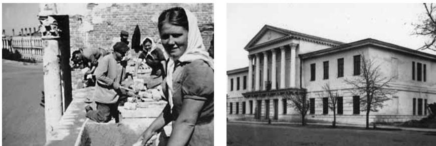
На відбудові будівлі Дворянського зібрання. 1945 Кінотеатр (Дворянське зібрання), 1946
