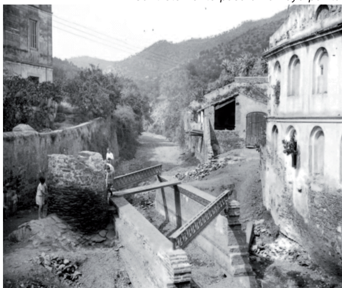
Figura 2, Construcció del Pont de la riera de les Comes. Al costat, el pou de cal Marí (P-16). Al fons el Trull de cal Pòlit. Any 1926. Arxiu Galán de Fotografia (AGF)
