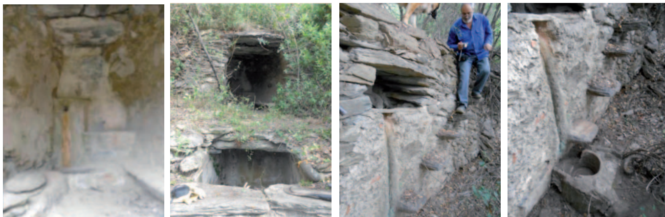
Figura 12. Font del Portuguès. Interior de la balma amb la font i un gravat en pedra del Sagrat Cor, el primer dipòsit. escales i segon dipòsit i detall del sobreexidor
