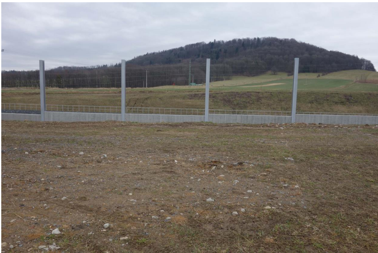
Stavba dálnice D 48 v Libhošti. V pozadí Libhošťská hůrka (494 m n m.). Pohled ve směru na jihovýchod. V rozježděném materiálu z výkopů výskyt pazourků. Foto A. Uhlíř 2020.
