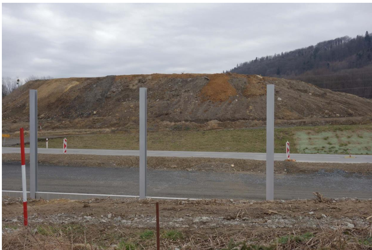
Stavba dálnice D 48 v Libhošti. Pohled ve směru na jihovýchod. Vpravo část Libhošťské hůrky. Foto A. Uhlíř 2020.
