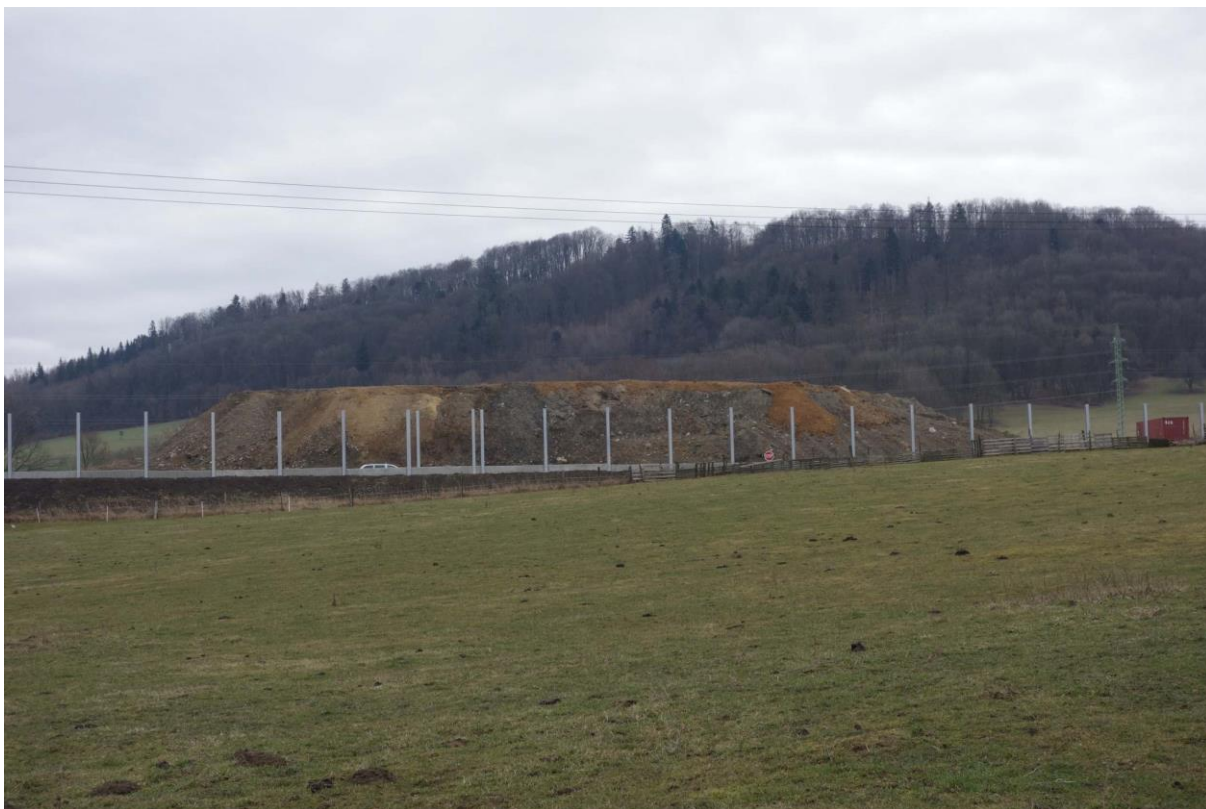
Stavba dálnice D 48 v Libhošti. Pohled na Libhošťskou hůrku ve směru na jihovýchod. Foto A. Uhlíř 2020.
