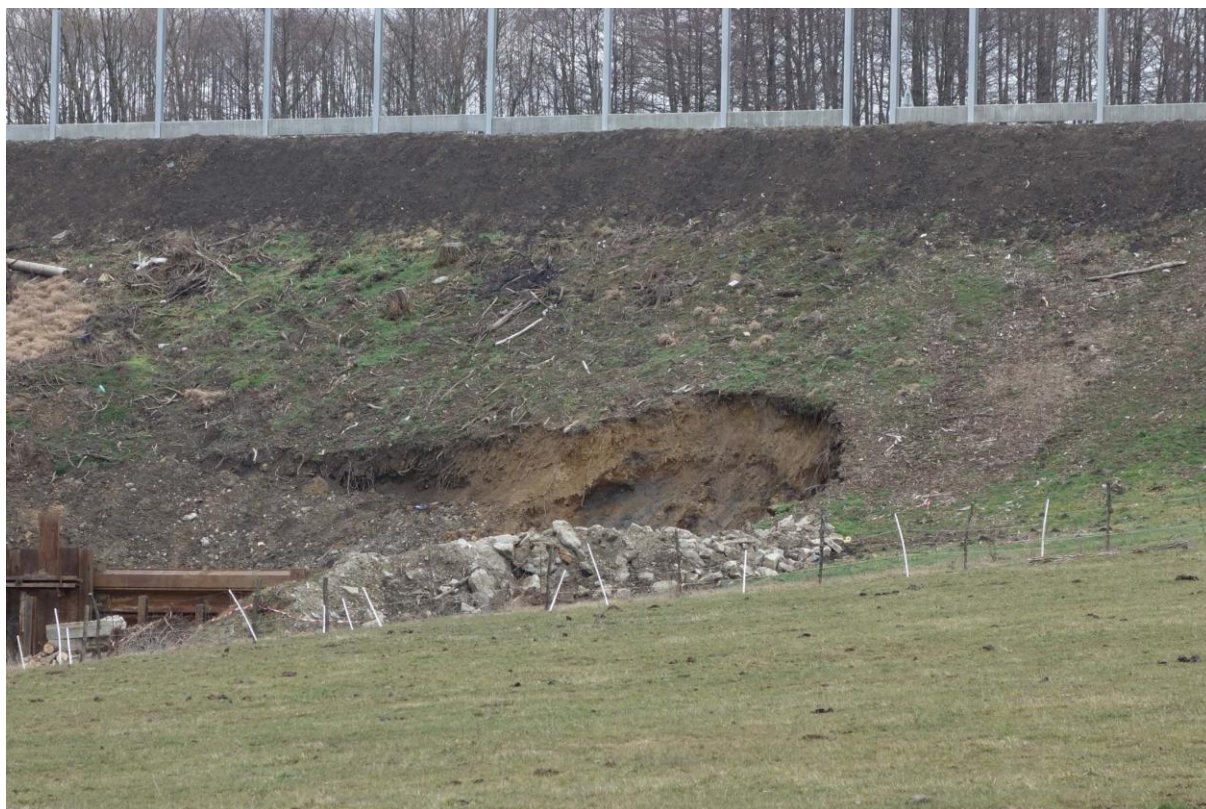
Stavba dálnice D 48 v Libhošti. Foto A. Uhlíř 2020.
