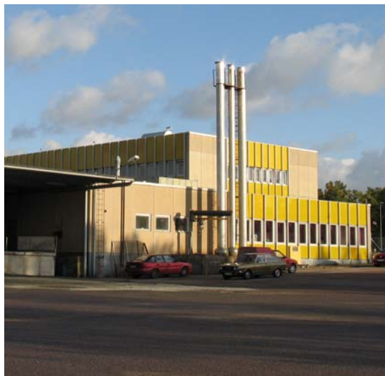
En vacker och tidstypisk industribyggnad, uppförd av det kommunala Oskarshamns Industrilokaler 1966, ursprungligen för snabbtefontillverkaren Gylling & Co, senare LM Ericsson.
