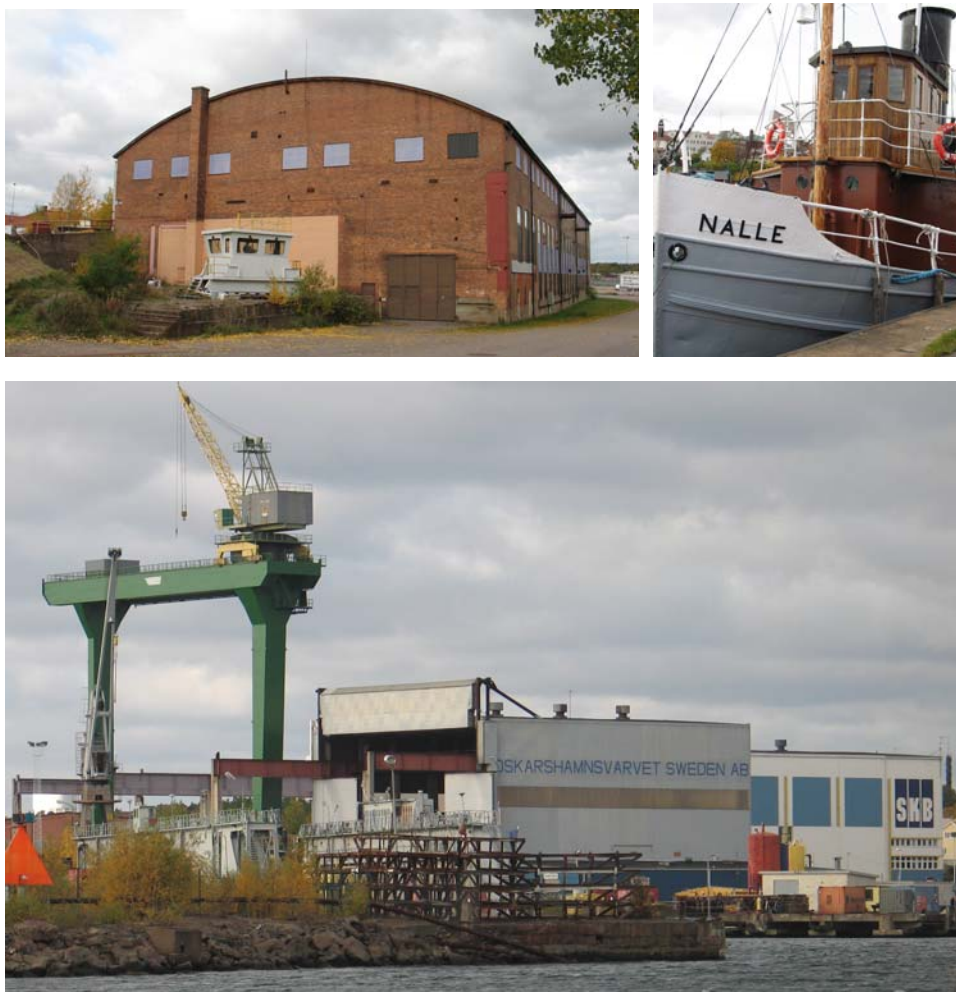
Överst t.v. Verkstad 14, en av de bevarade byggnader som hört till mekaniska verkstaden och varvet. Överst t.h. S/S Nalle. Nederst: Oskarshamns varv med bockkranen.
