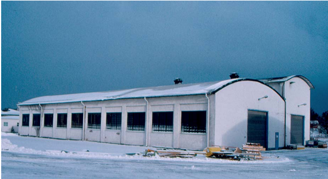
ABB:s äldsta lokaler som ursprungligen uppfördes för Baltiska Dock.
