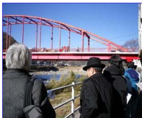
修善寺橋における現地調査（伊豆市内）
