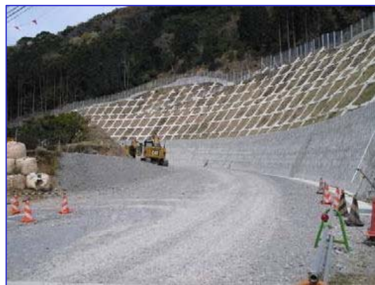
建設中の国道136号土肥拡幅
