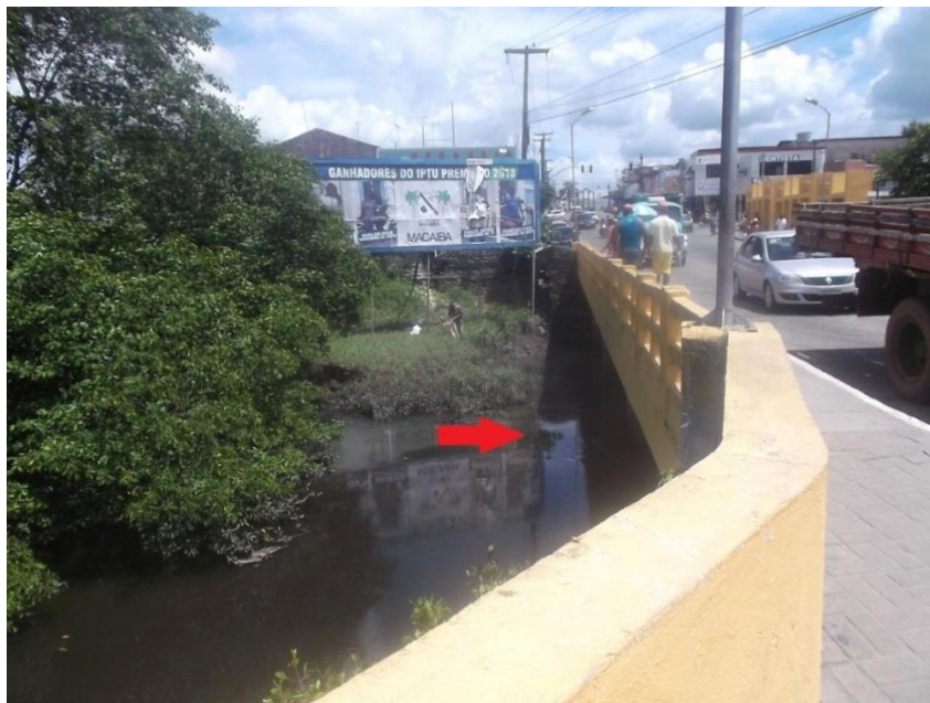
Figura 08: Ponte cruzando o rio Jundiáí no trecho urbano da cidade de Macaíba. Seta em vermelho indica sentido de escoamento do rio. Fonte: O autor
