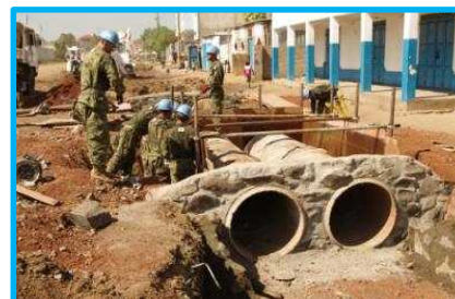
【南スーダンPKOにおける道路整備】
