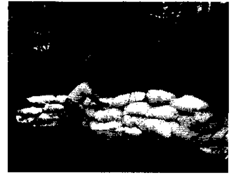
Uno de los técnicos de la unidad Villahermosa coloca costales de tierra en el cauce de un arroyo para así prevenir la erosión (Foto: Salvador Hernández Daumás).
