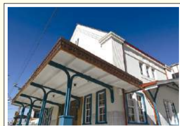
▲屋外のひさし柱(写真手前と一番奥)には、イギリスやアメリカ製の古レールを使っています。また、建物の軸組みに用いている木材の約7割は、創建時の部材を再利用しています。
