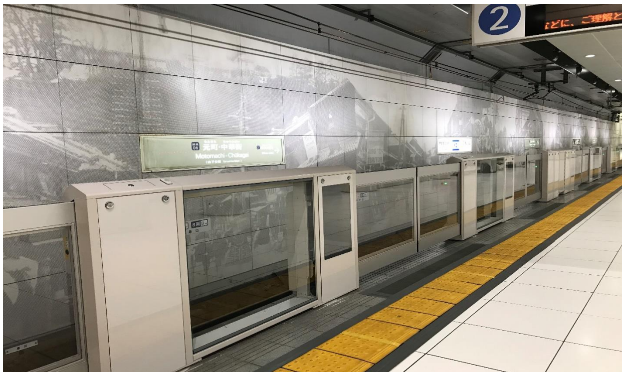
元町・中華街駅可動式ホーム柵整備状況 (可動式ホーム柵の配色は駅構内に合わせています)
