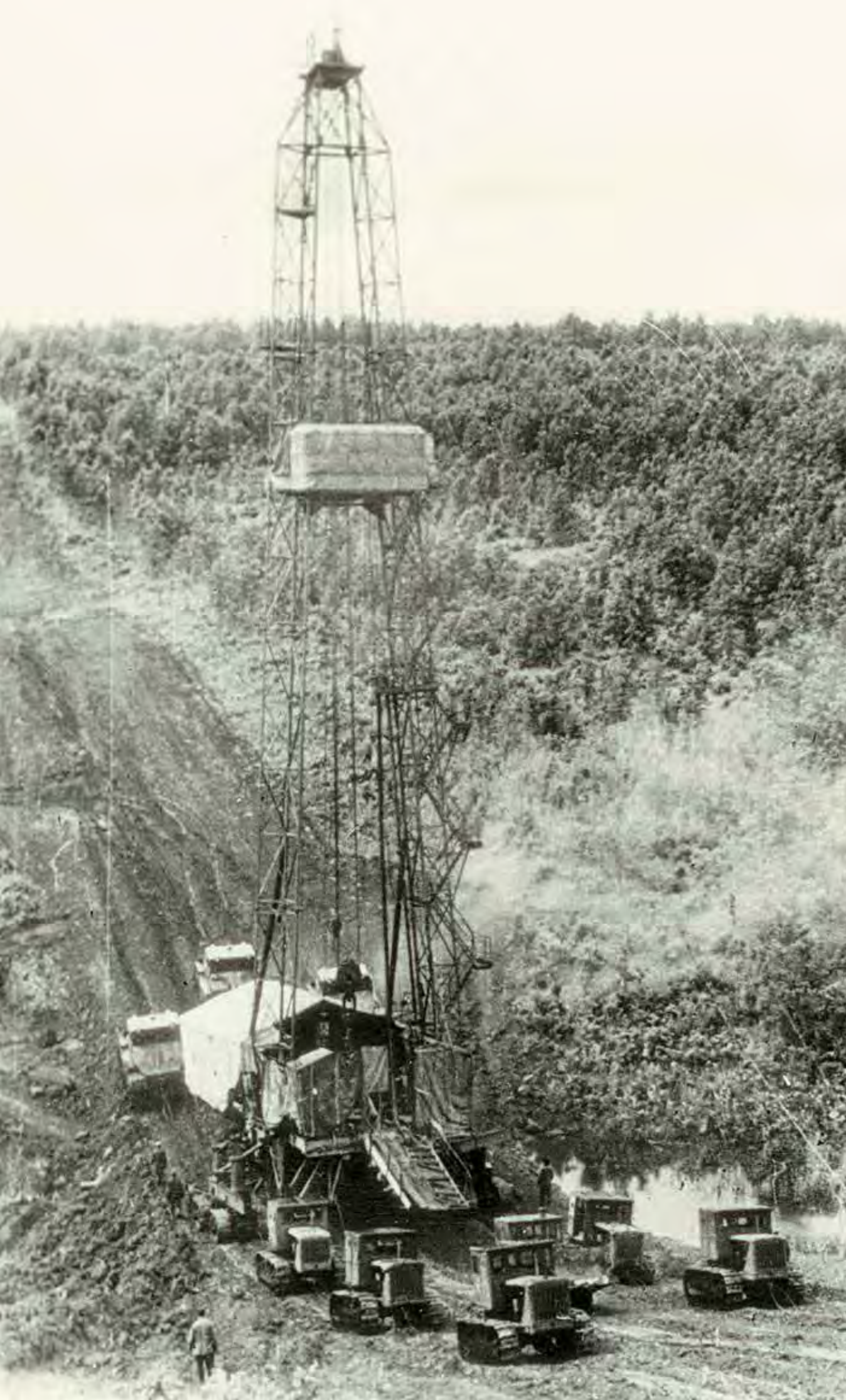
Передвижка буровой установки без демонтажа силового и агрегатного оборудования. Конец 1950-х годов
