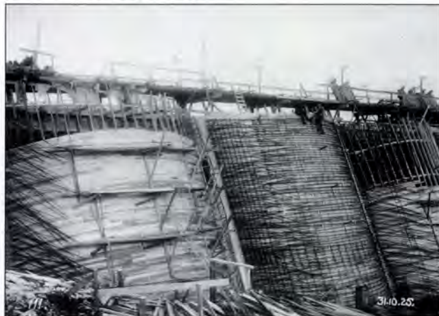
Intagsdammen. Valven under formsättning och armering. Foto Tor Ekholtz 31 oktober 1925.
