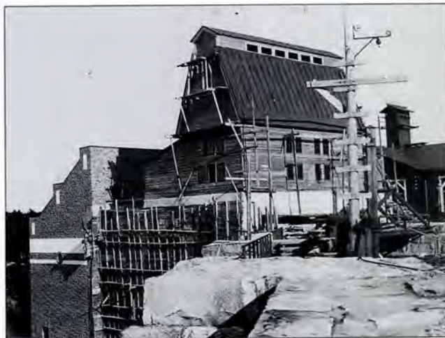
Bygget av nya verket med det timrade intagshuset ännu utan panel. Fotot tillhör Kraftverksföreningen i Stockholm.
