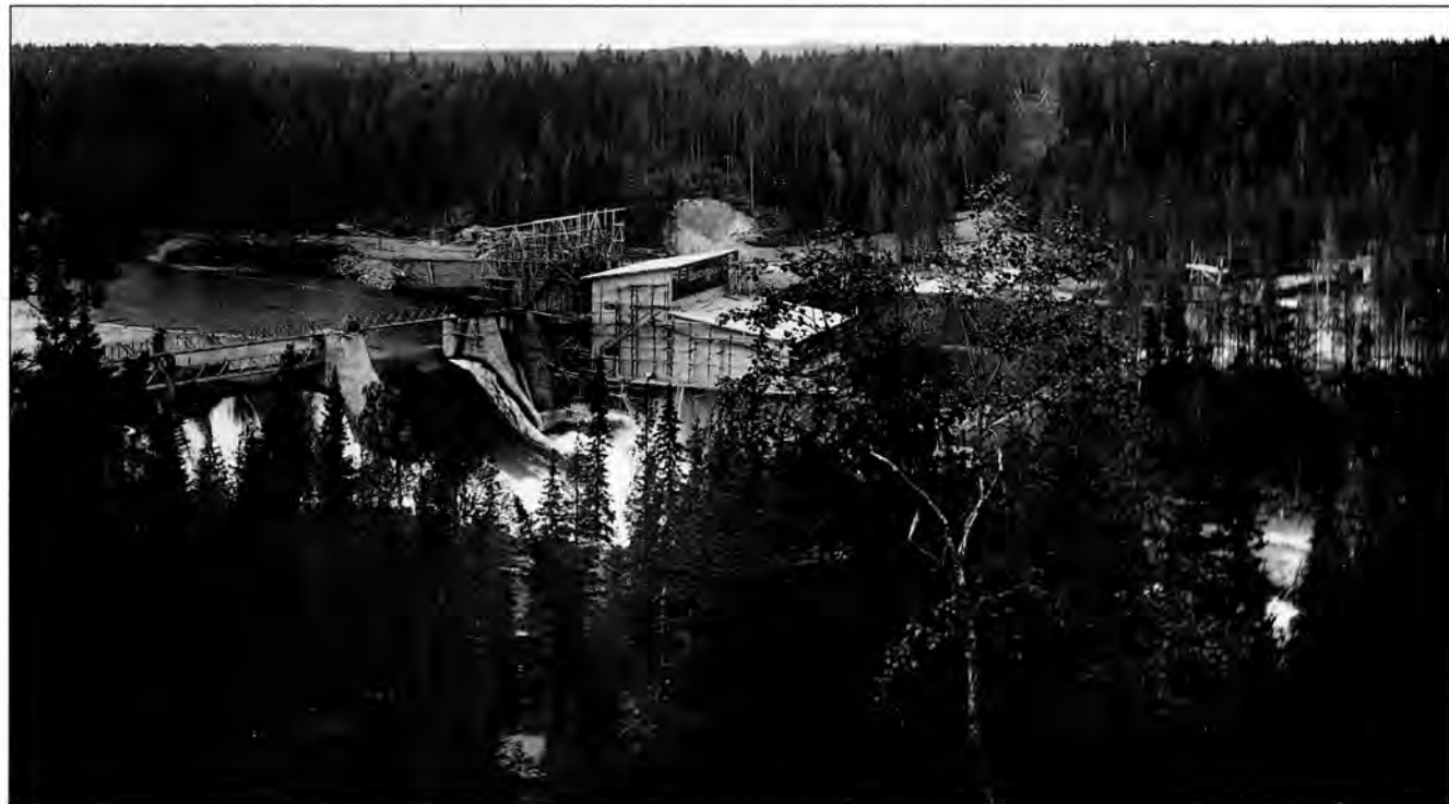
Krångfors kraftverksbygge 1927. Intagsbyggnaden är under uppförande. Foto i Skellefteå museums arkiv.
