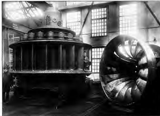
Led- och löphjul till en av Norrforsturbinerna. Verkstaden, Kristinehamn. Foto i Kraftverksföreningens arkiv, Stockholm.
