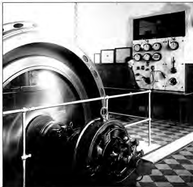
Interiör från kraftstationen i Fredriksfors år 1920. Foto i Västerbottens museum.
