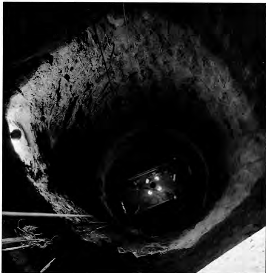
Schakt för en av de tre vertikala tuberna till turbinerna i Stornorrfors. Schaktet är ca 70 m djupt och har en diameter av 8 m. Foto: Arne Persson / Vattenfall 1956.
