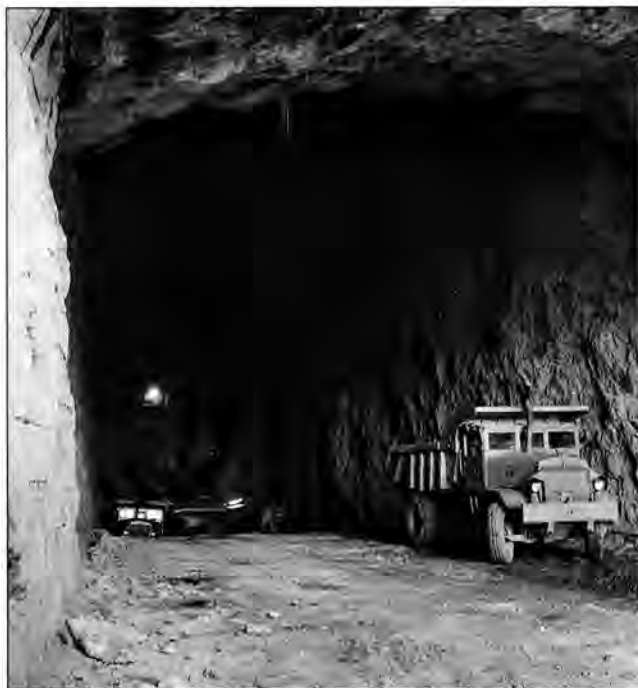
Djupsprängning och utschaktning för ett av de tre intagen. Foto: Vimar Ericsson / Vattenfall i november 1959.
