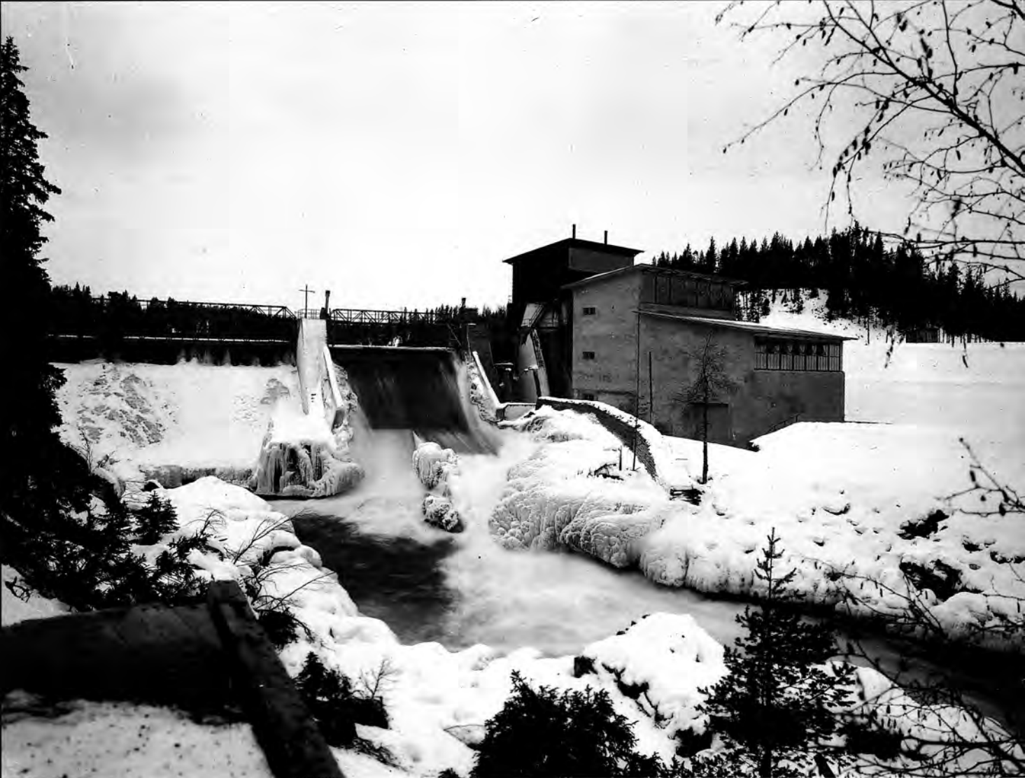
Krångfors kraftverk efter färdigställandet, förmodligen vintern 1928–29. Foto i Kraftverksföreningens arkiv, Stockholm.
