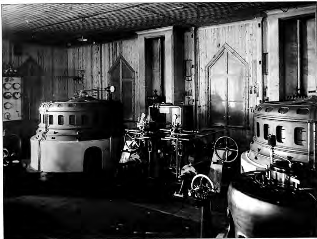
Interiör från maskinhuset i Klabböle år 1900 med originalmaskineriet och de säregna regulatorerna mellan generatorerna. I bakgrunden syns murade nischer med kaminer. Foto i Västerbottens museums arkiv.
