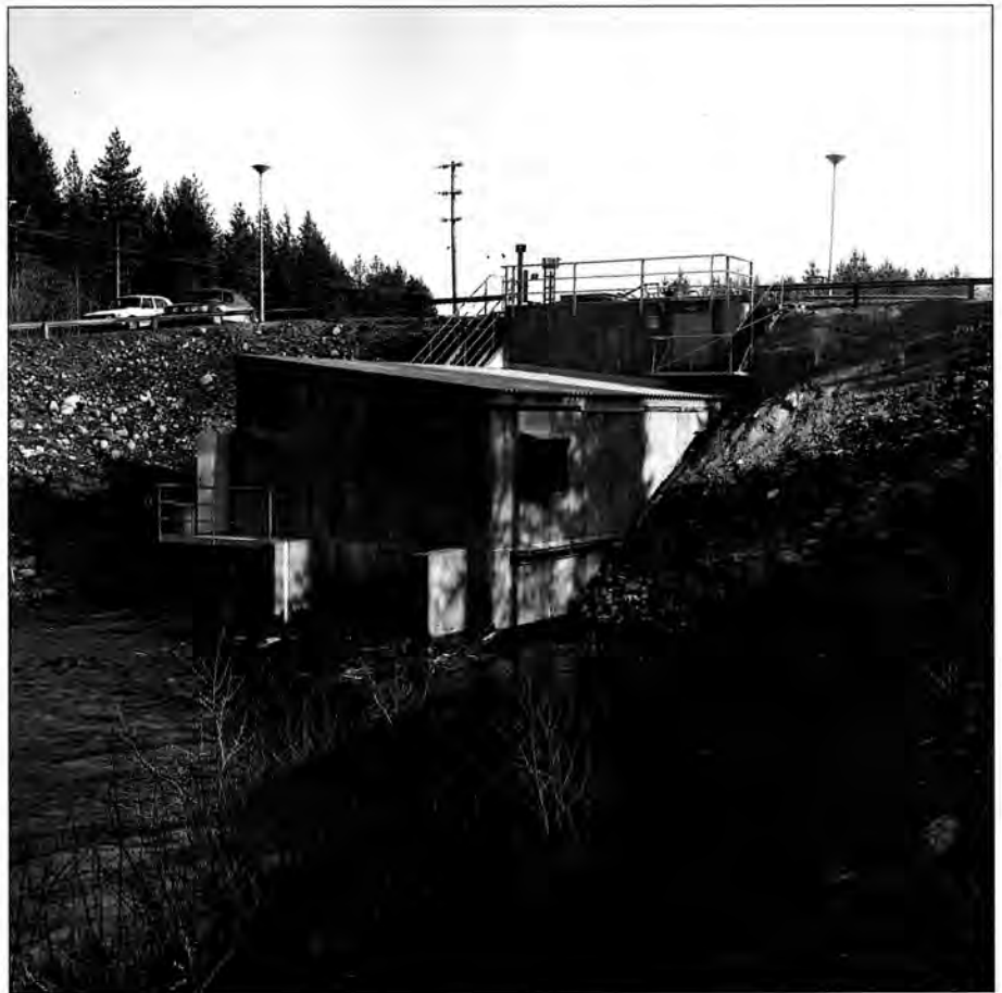
Stormmyrforsens minikraftverk i Bureälven. Foto: Bengt Spade 1992.
