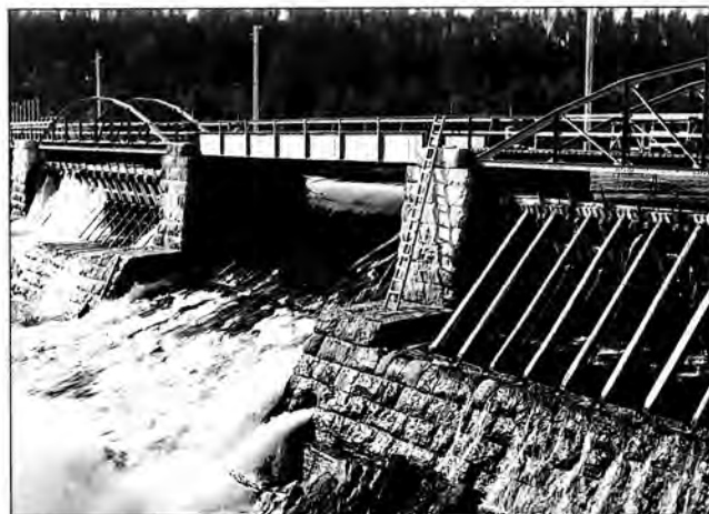
Finnforsdammen år 1936. Dammöppningarna är från vänster till höger avstängda med spettluckor, staffiluckor, Bear-trapluckan samt staffiluckor. Foto i Skellefteå museums arkiv.
