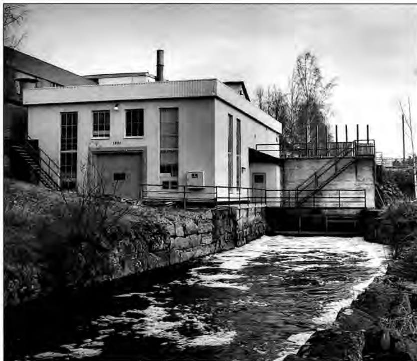
Bruksforsens kraftverk i maj 1992. Maskinhuset i typisk "funkisstil" till vänster och den öppna turbinsumpen till höger. Foto: Bengt Spade.
