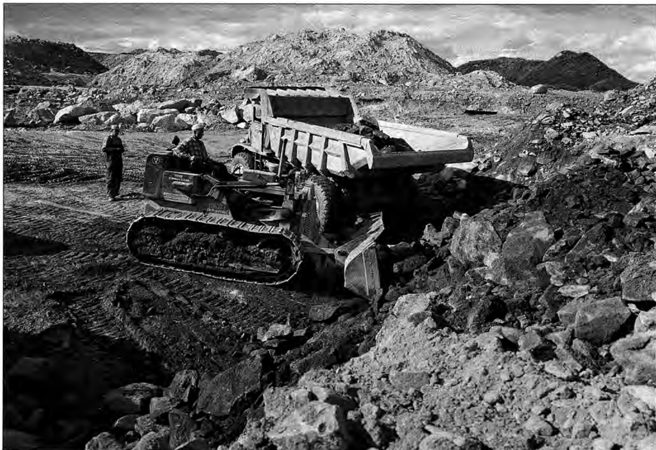
Schaktningsarbeten ovan jord för tillloppskanalen i Stornorrfors. Foto: Lennart Nilsson / Vattenfall 1958.
