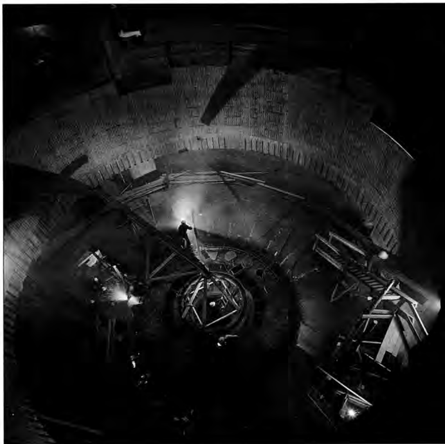
Rotorgropen för aggregat 1 i Stornorr-fors fotograferad uppifrån före montage av armkorset med bärlager samt rotorn. Nere i gropen syns turbinspiralen och turbinlocket med den ännu ej färdigmonterade ledskenustrustningen. Foto: Lennart Nilsson / Vattenfall 1958.
