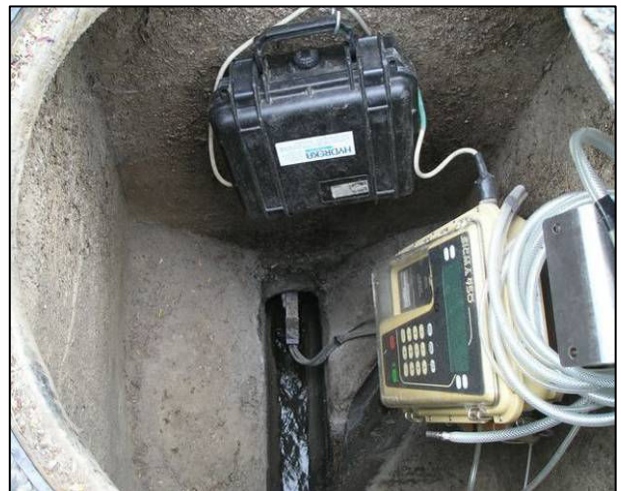
Installation du Débitmètre Bulle à Bulle dans un regard
