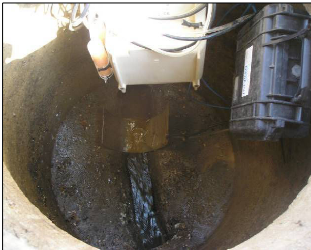
Installation du bulle à Bulle +doppler dans un seul regard
