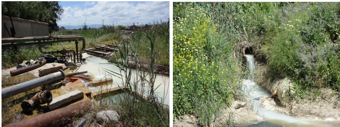
Figure 20 : caniveau d'évacuation et rejet des effluents
