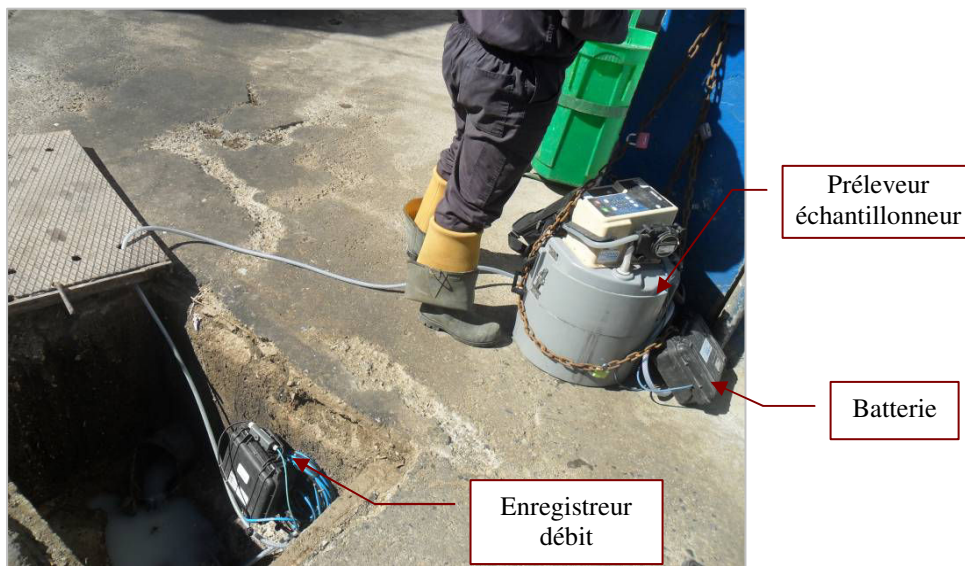
Figure 24 : Installation du matériel de mesure
