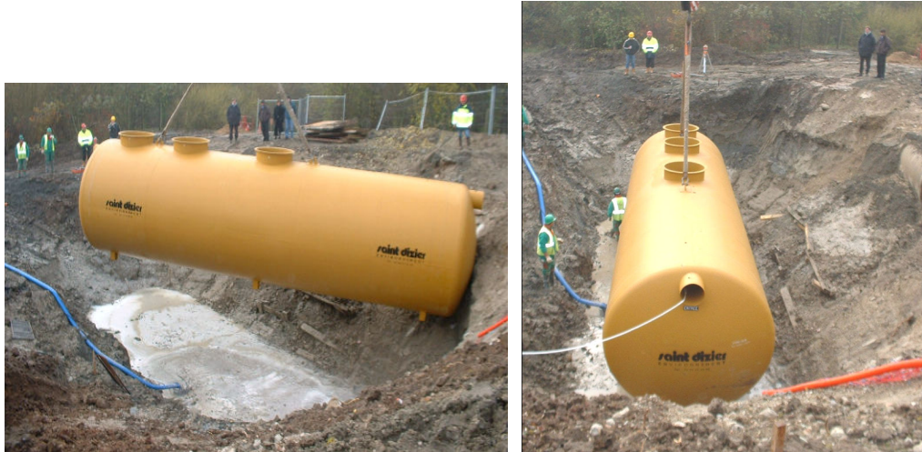
Figure 31 : Mise en place d'un déshuileur
