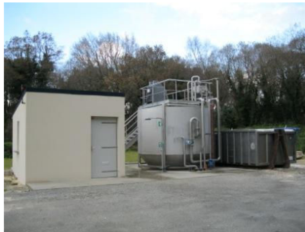
Figure 27 : Exemple d'installation de traitement physico-chimique par aéroflottation
