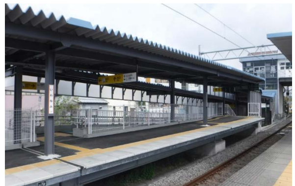
写真2. 新上りホーム
