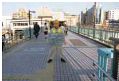
自由通路部施工前
