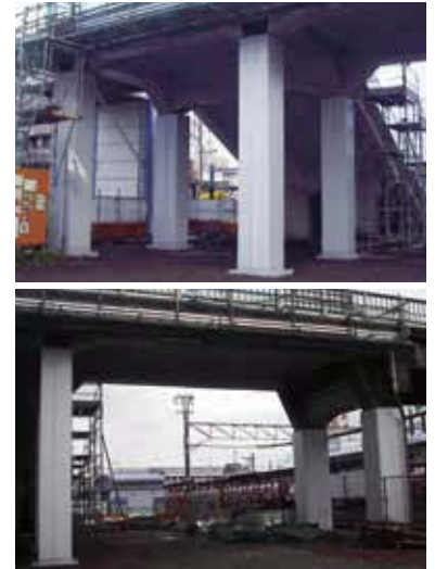
耐震補強工完了
