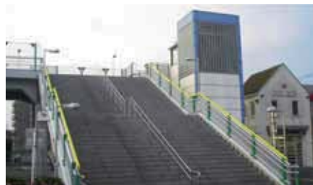
階段部施工後
