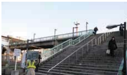
階段部施工前
