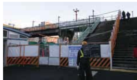
階段部ガードフェンス
