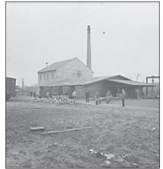
Danckerts Plads på Sønderbrogade 31, som det så ud dengang i 1906. Og her er der da gang i en lille fabrikk, Træfabrikken Thor.
