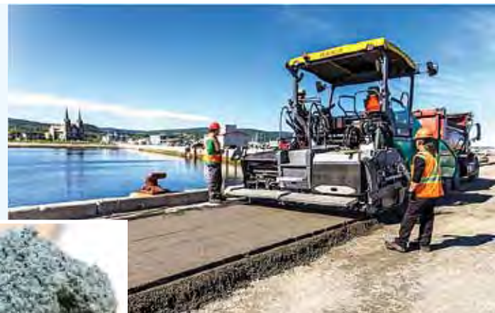
Покриття з укоченого бетону можна влаштовувати на будь-яких дорогах, навіть на ділянках з інтенсивним рухом важкого транспорту
