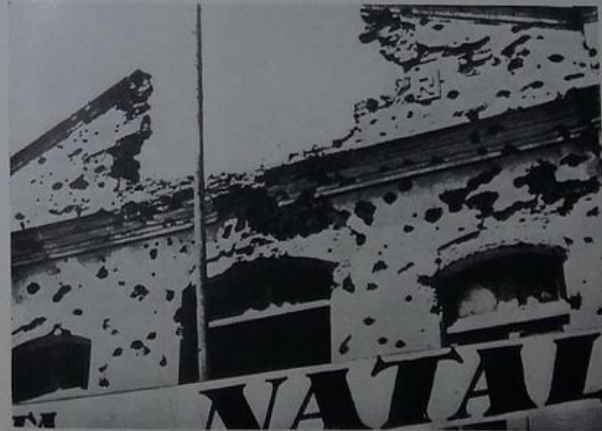
106. Die Fassade einer Polizeikaserne, die während der kommunistischen Revolte 1935 mit Maschinengewehren und Dynamitbomben beschossen wurde
