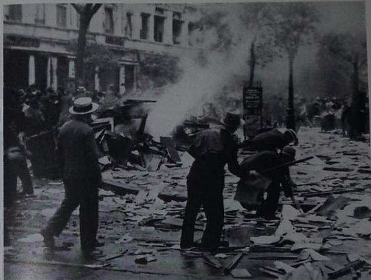
96. Das zerstörte Zeitungsgebäude „O PAIZ“ in Rio
