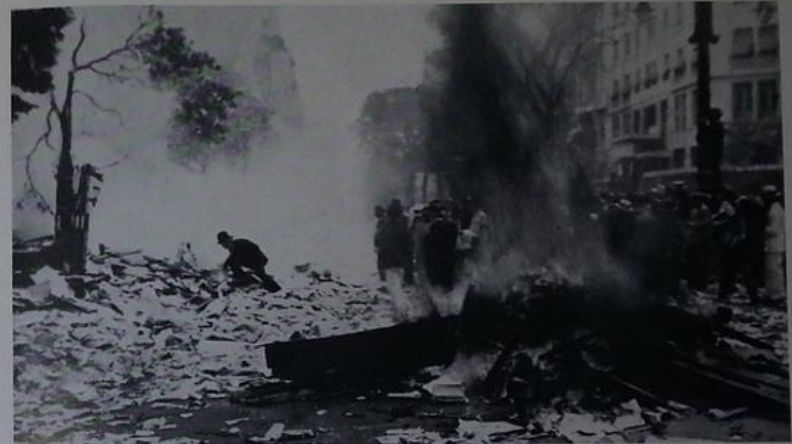
98. Die Zerstörung des Verlagsgebäudes des „Journal do Brasil“ in Rio de Janeiro
