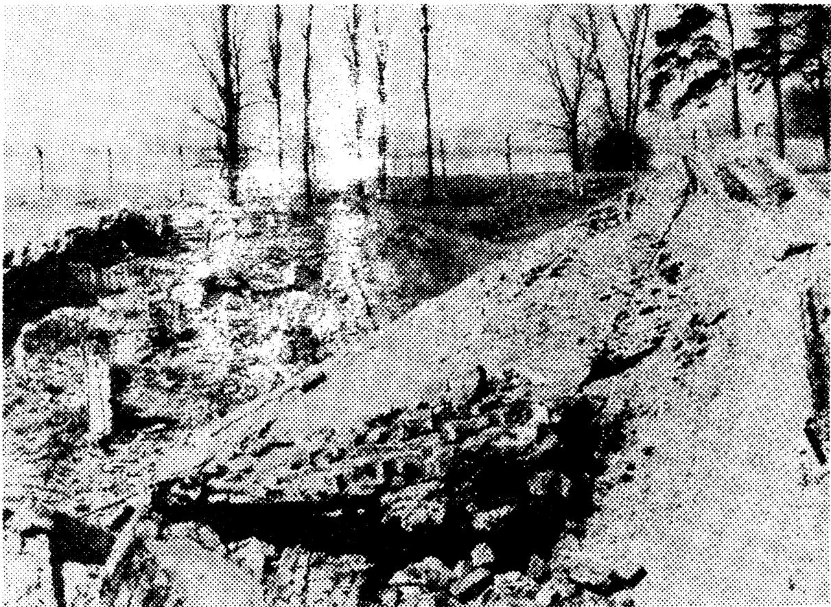
Gesprengtes Hauptgebäude Krema II, Auschwitz-Birkenau.
