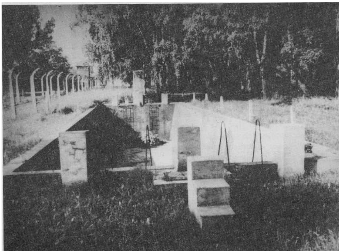
Im Auschwitz-Lagerbereich unmittelbar hinter Block 6 gelegenes Schwimmbad mit Sprungturm, erbaut während der Kriegszeit.
