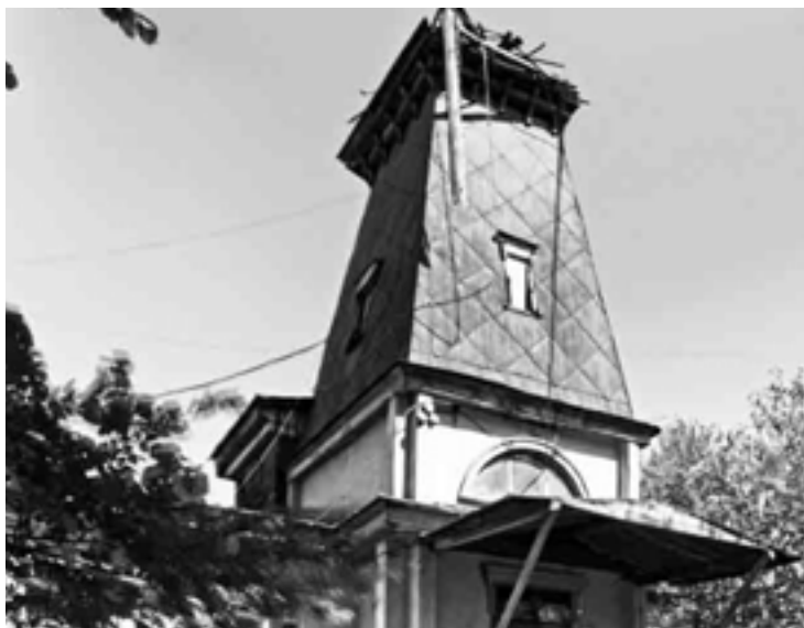
Верненская метеостанция после реконструкции.
