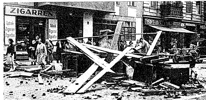
Barrikaden in der Rostocker Straße Moabit, Juni 1932.
