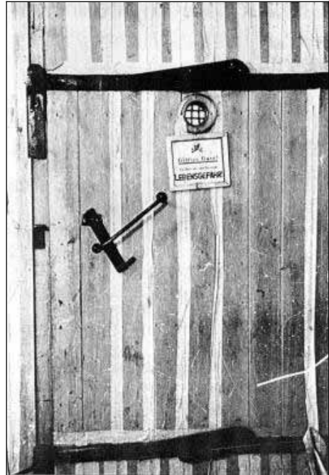
Tür einer Entlausungskammer in Auschwitz mit Guckloch und Metallgitter davor.
