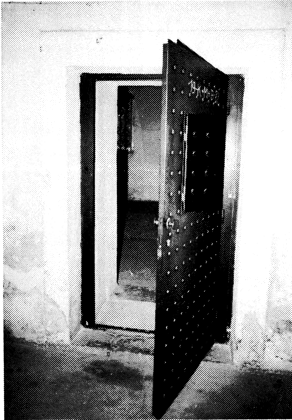
Angebliche »Gaskammer« Tür mit Guckluken; im Hintergrund der »Gaskammer« sieht man deutlich das vergitterte Fenster.
