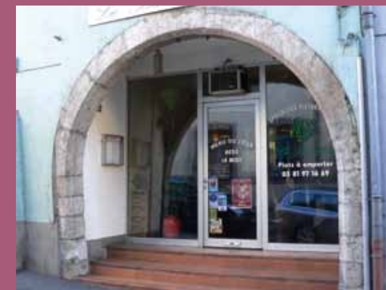
N°4 Rue du château
