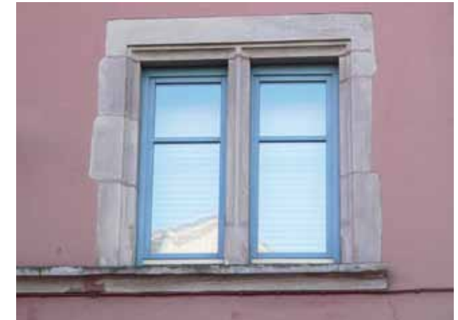
Fenêtre s'appuyant sur un bandeau - Rue Diemer-Duperret
