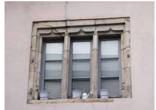
Fenêtres à meneaux triples - Rue de Belfort
