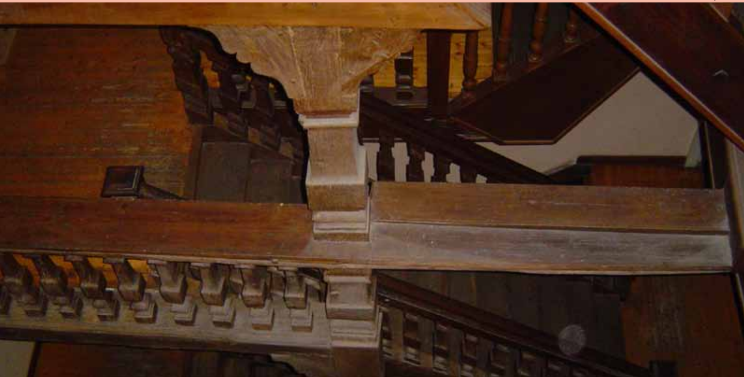
Escalier à volées droites : ensemble monumental N° 14 rue Diemer Duperret
