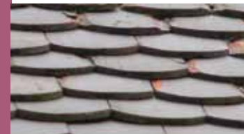
Toiture en tuiles écailles de l'Hôtel de Franquemont
