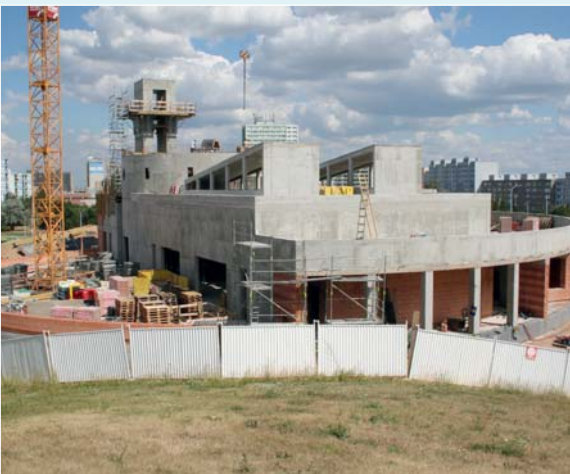
Stavba v plném proudu 2. 8. 2006
