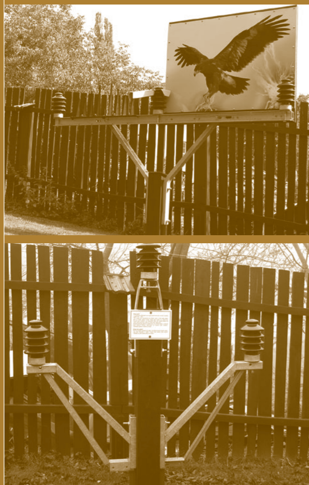
Z expozice: nahoře nebezpečná konstrukce sloupu vysokého napětí - tzv. sloup smrti, dole bezpečná konstrukce, zvaná „pařát“.
