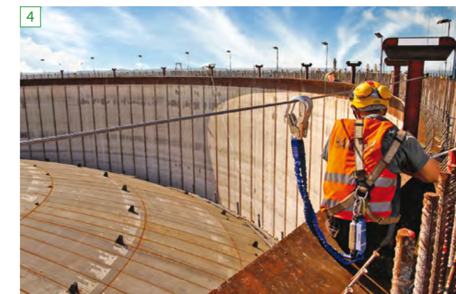
fot. 1-4. Budowa Gazoportu w Świnoujściu. LNG Terminal in Świnoujście.
