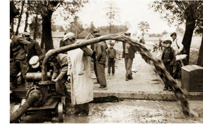
fol. Budowa Gazociągu Centralnego. Construction of the Central Gas Pipeline.
