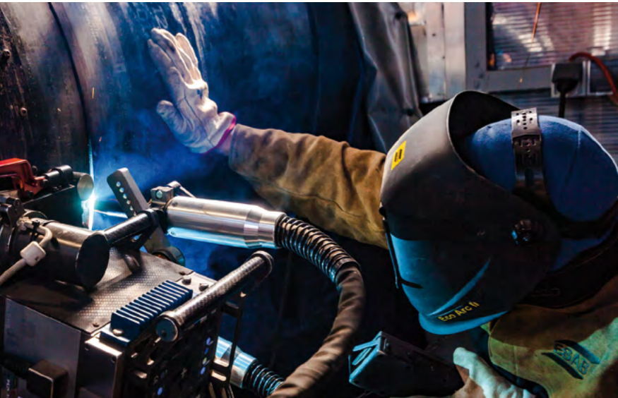
Spawanie metodą CRC Evans – budowa gazociągu Strachocina – Pogórska Wola CRC Evans welding – Strachocina – Pogórska Wola gas pipeline construction
