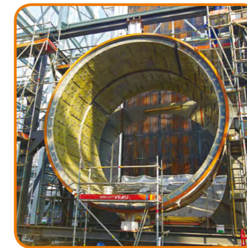
Budowa bloku gazowo-parowego w Ec Żerań. Construction of the gas and steam unit in CHP Żerań.
