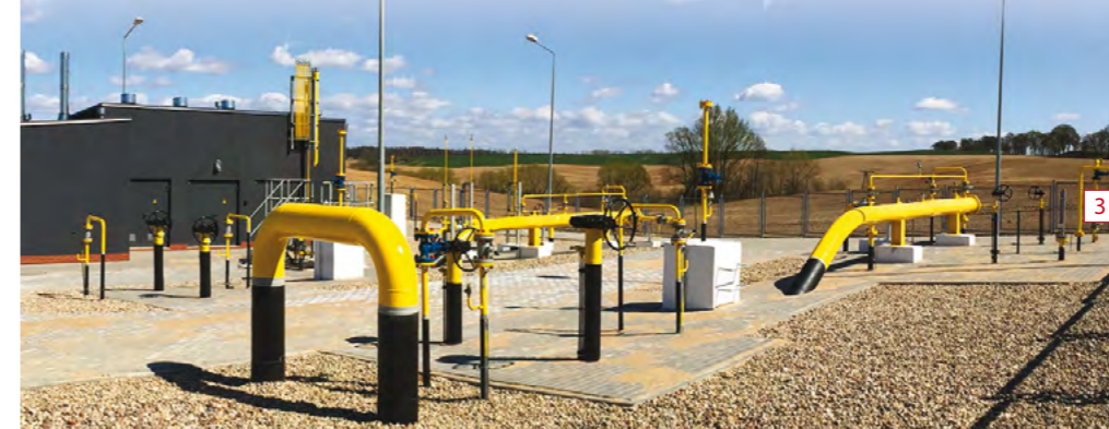
fot. 2. Węzeł Transgraniczny Hermanowice, systemy pomiaru przepływu z gazomierzami MPU. / Custody Transfer Substation Hermanowice, gas flow metering system with USM/MPU gas meters.
