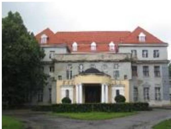
Fot. 4. Pałac z 1918 r. w Gronowie (źródło własne)
