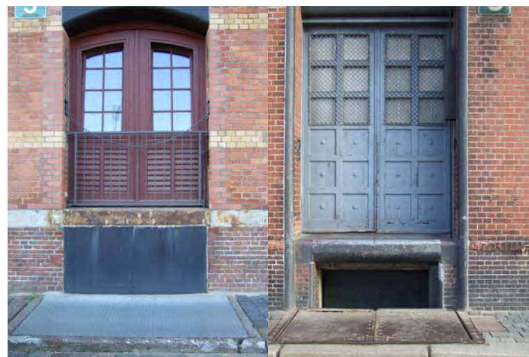
Abbildung 28: Schließung einer Kellerluke mit Beton Abbildung 29: Kellerluke in Funktion
