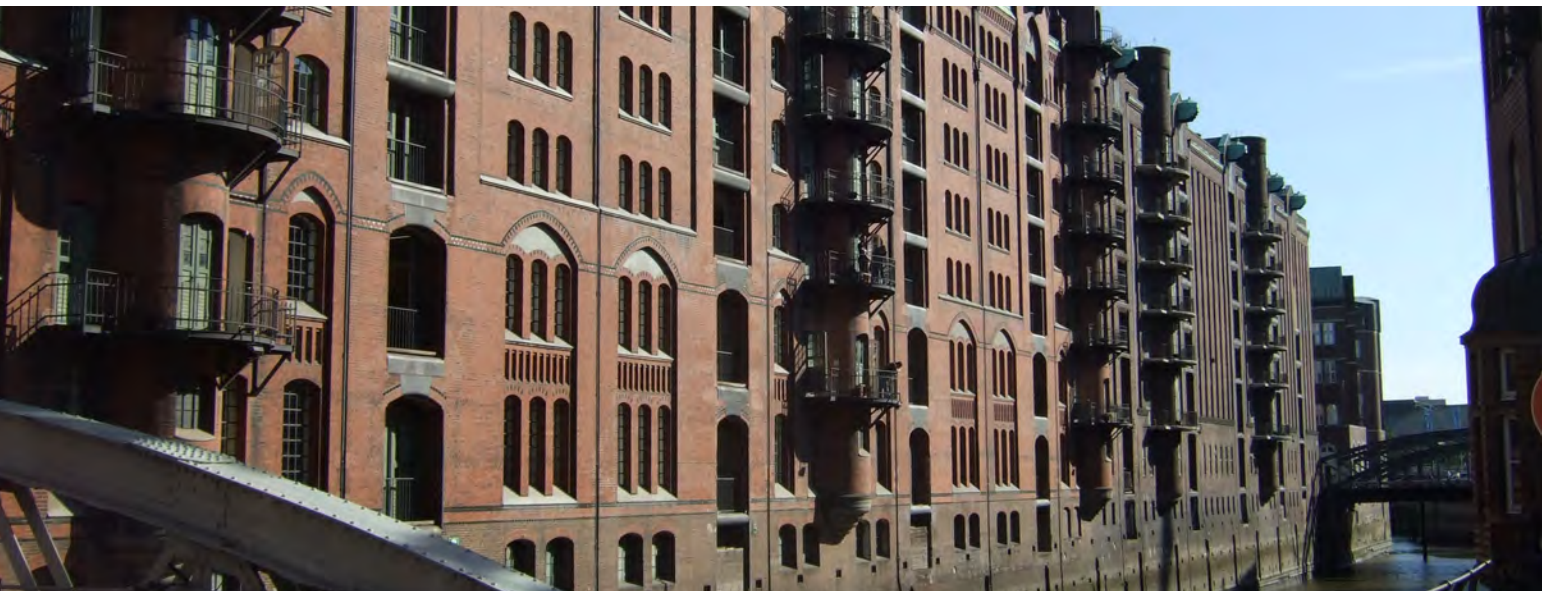
Abbildung 99: Ansicht Süd des Speicherblocks W
