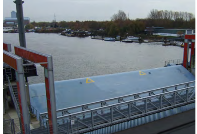
Abbildung 15: Sperrwerk Billwerder Bucht
