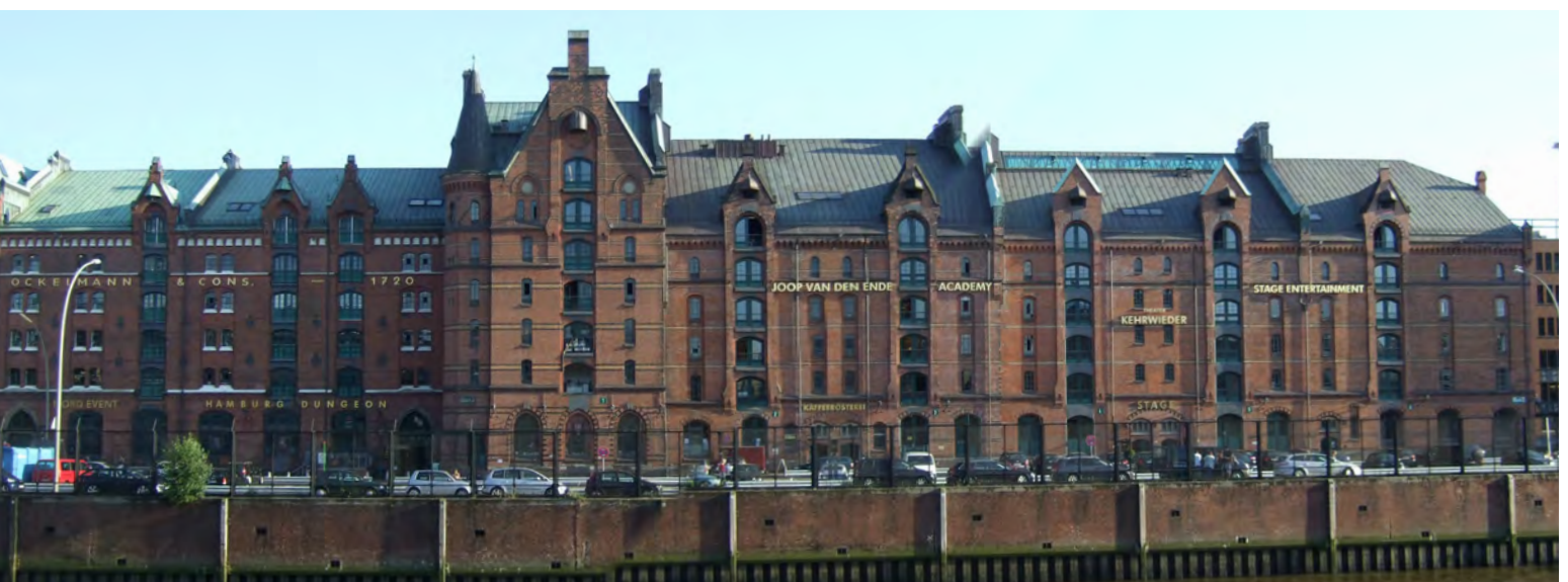
Abbildung 69: Ansicht Nord des Speicherblocks D
