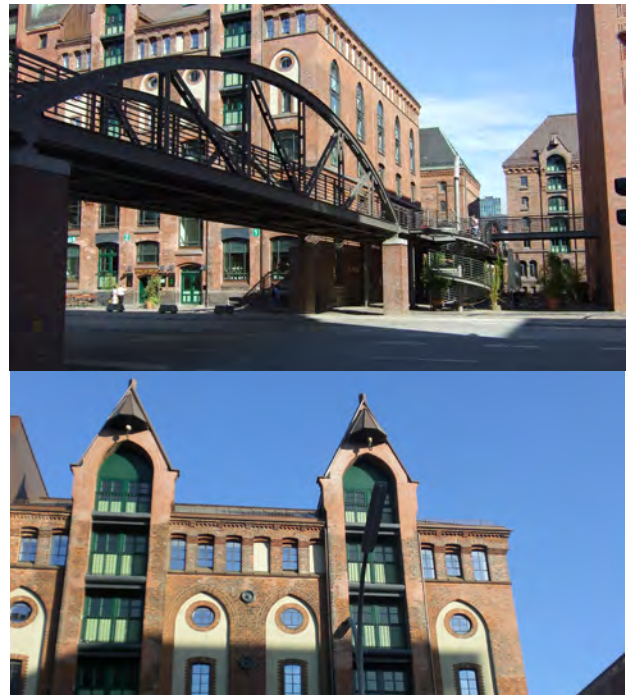
Abbildung 8: Kibbelstegbrücke und Kaispeicher N
