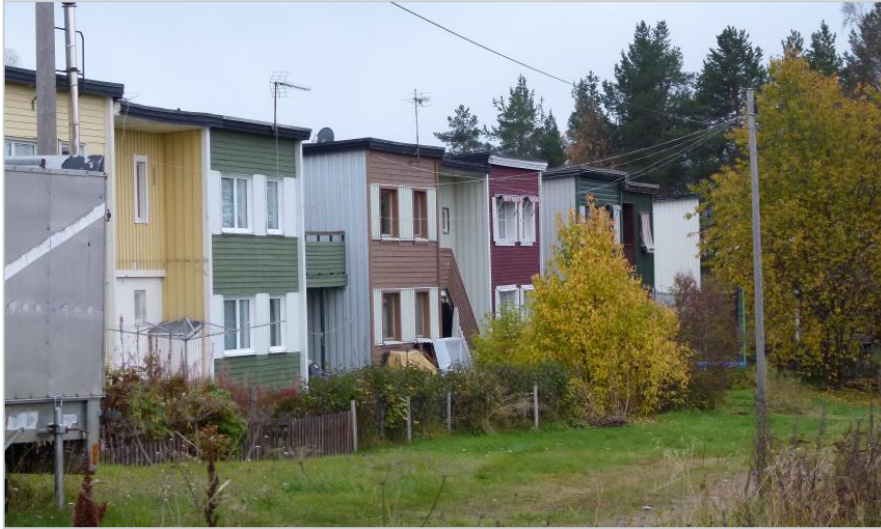
Baksidan av husen längs Murgatan.
