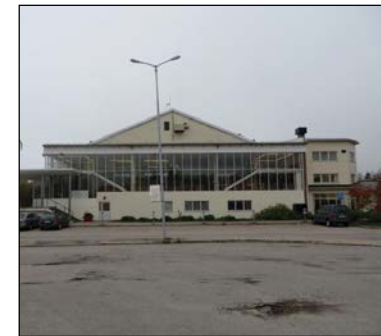
Sporthallen mot Järnvägsgatan.
