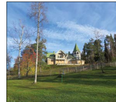
Disponentvillan från Bolagsvägen.
