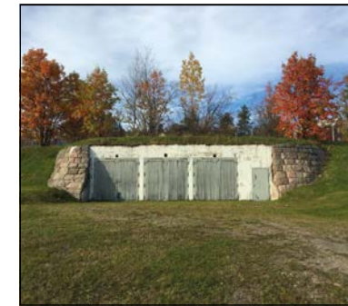
Garage/skyddsrum vid Hermelinsbacken
