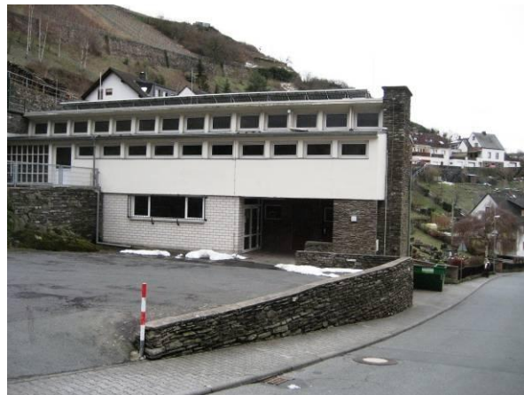
Abb. 3.7: Dorfgemeinschaftshaus Lorchhausen (ehemalige Schule)
