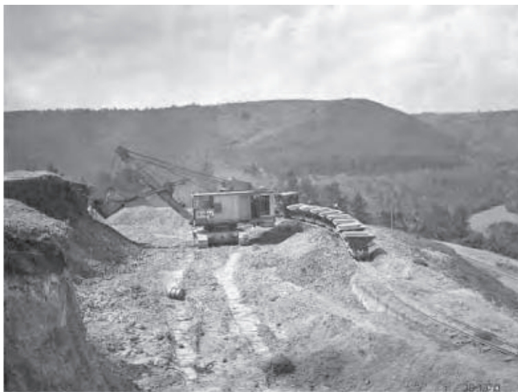
Rypadlo Škoda a parní lokomotiva ČKD firmy Funke na stavbě dálnice jižně od Nebovid (km 520)
