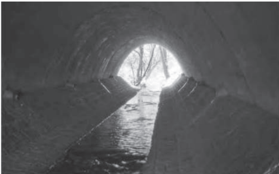
Detail koryta a klenby mostu (1986), (km 499,9)
