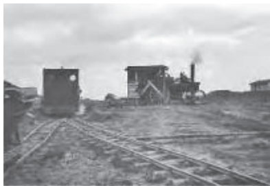
Práce na dálnici severně od silnice z Černé Hory do Býkovic 10. listopadu 1940
