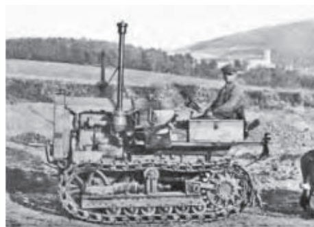
Pásový traktor značky Hanomag na stavbě dálnice. V pozadí zámek v Černé Hoře
