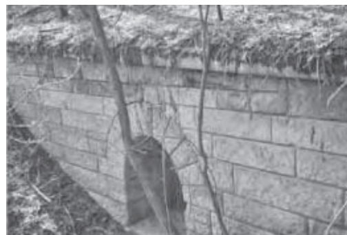
Propustek v dálničním násypu jižně od Želešic (2004), (km 523,6)
