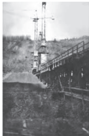
Věžové jeřáby a kabelový jeřáb (1941)
