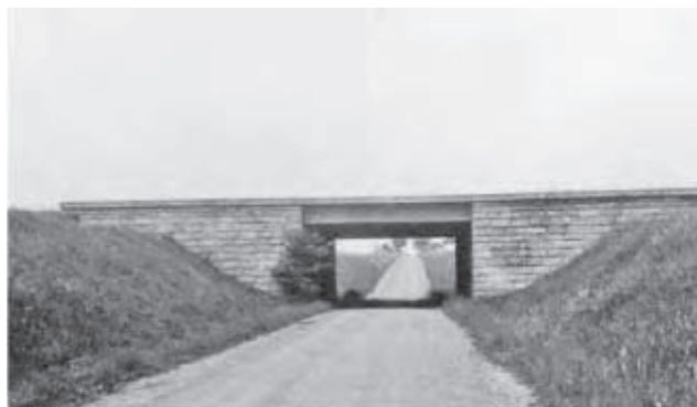
Celkový pohled na dálniční most ze Syrovic do Vojkovic (1962), (km 526,8)
