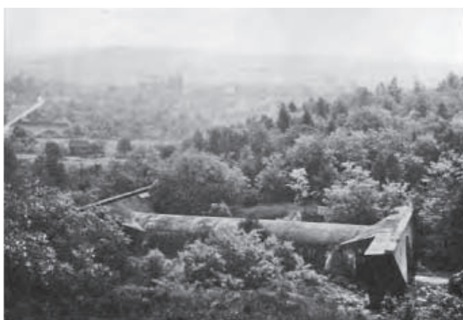
Dálniční most přes místní komunikaci a potok v Želešicích – celkový pohled (1962), (km 521,4)
