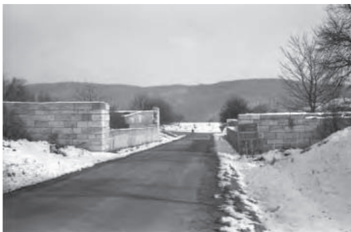
Celkový pohled na rozestavěný most u obce Rozdrojovice (1985), (km 505,9)
