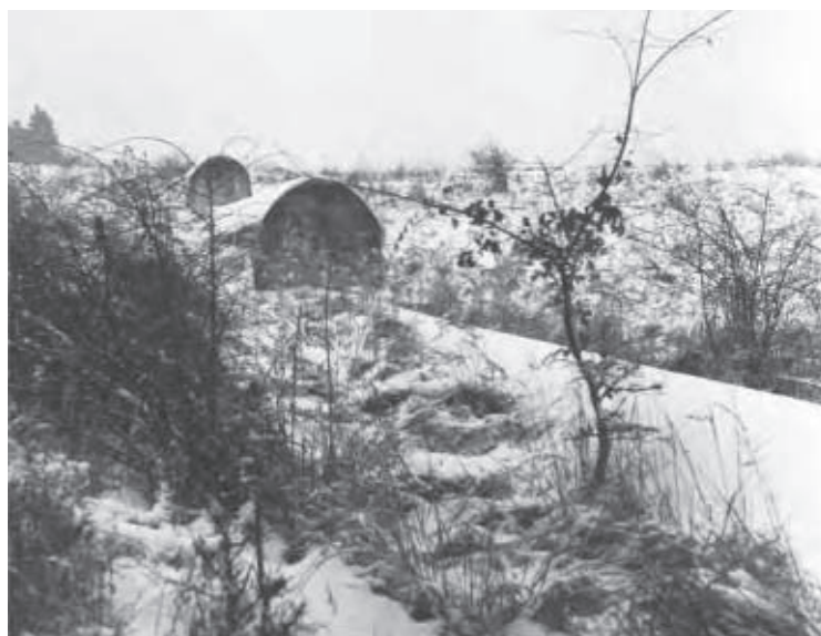
Stupňovitý propustek na severním předmostí západního viaduktu (km 488,7)
