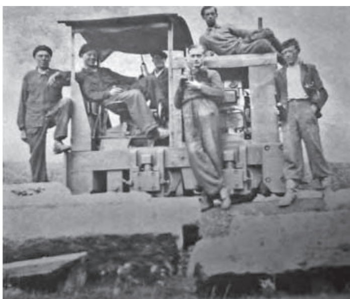
↕ Motorová lokomotiva značky Orenstein & Koppel typ MD-2. V popředí snímků jsou kamenné kvádry určené pro stavbu dálničních mostů
