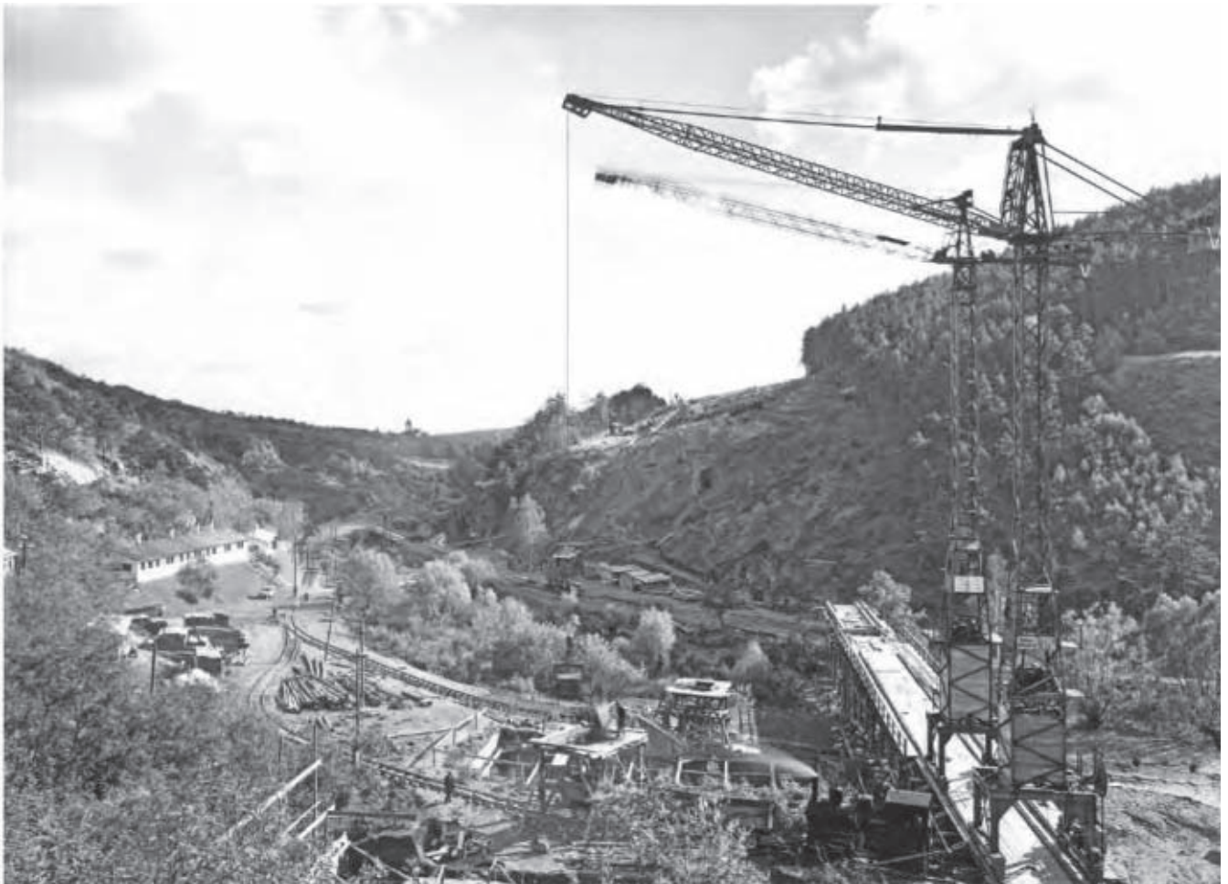
Celkový pohled na staveniště dálničního mostu přes údolí říčky Obravy (nyní Bobrava) u Želešic (520,7)
