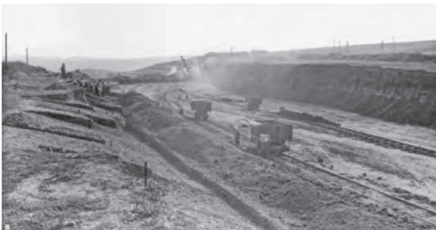
Zemní práce u obce Kníničky, v pozadí dělnický ubytovací tábor (2)
