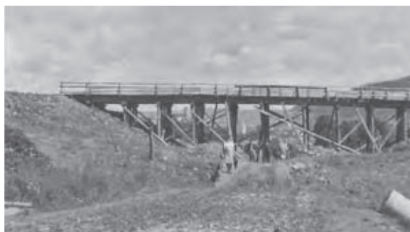
Detailní pohled na most pro stavební drážku (km 484,4)
