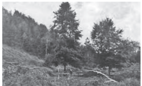
Kácení stromů v trase budoucí dálnice v údolí Šelše (1939)
