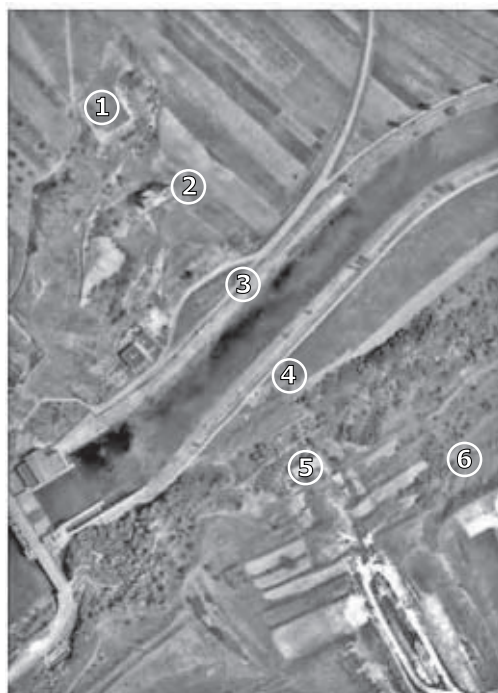
Dálniční most přes údolí Svratky u Brněnské přehrady (1947)
