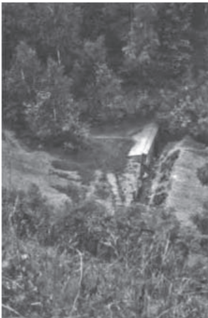
Pohled z násypu na propustek. Na hraně násypu se nacházejí zbytky kolejí stavební drážky firmy Funke (1962), (km 517,2)
