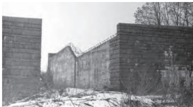
Nedokončený dálniční most se samostatně klopenými vozovkami přes polní cestu jižně od Nebovid (1986), (km 519,2)
