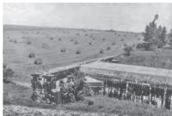
Detail římsy mostu (1962), (km 524,3)
