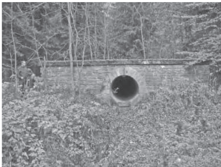
Dokončený trubní propustek u Žernovníka (km 486,5)
