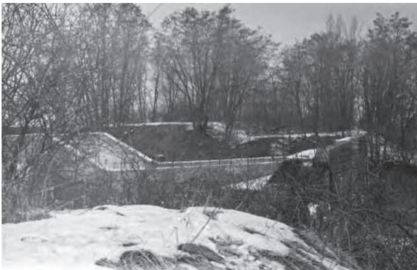
Pohled přes nedokončený dálniční most se samostatně klopenými vozovkami. Za mostem je dobře viditelná rozdílná úroveň dálničního tělesa pro každou z vozovek (1986), (km 519,2)
