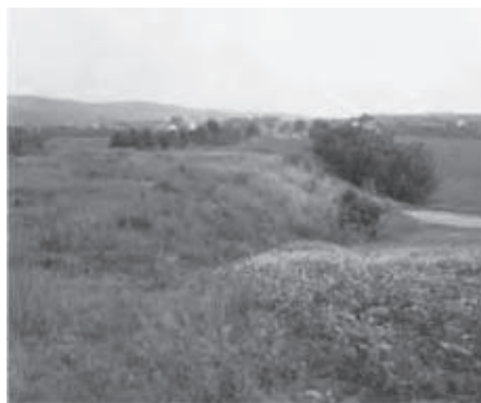
Těleso dálnice mezi dálničním mostem přes Svatku a původní zástavbou v Brně-Bystrci (1966), (km 507,4)
