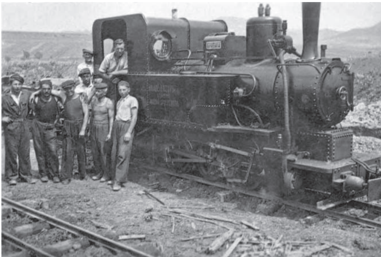
Parní lokomotiva značky ČKD na stavbě dálnice u Hlubokých Dvorů
