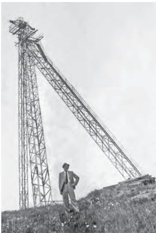
Konstrukce kabelového jeřábu na severní straně údolí říčky Lubě
