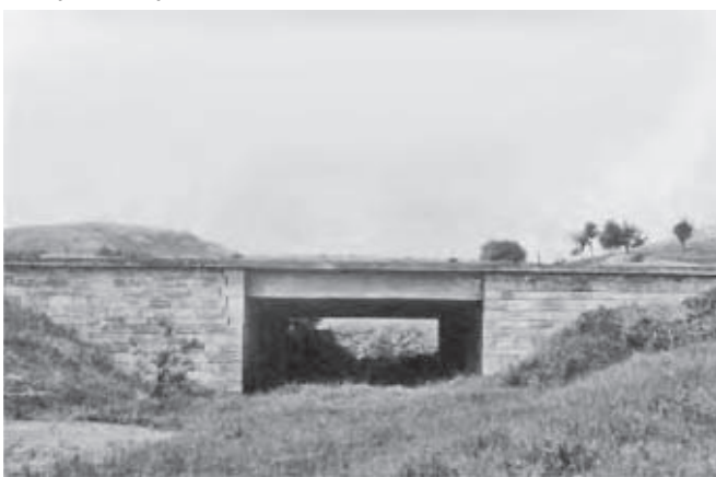
Dálniční most přes nedokončenou přeložku silnice z Želešic do Hajan (1962), (km 523)
