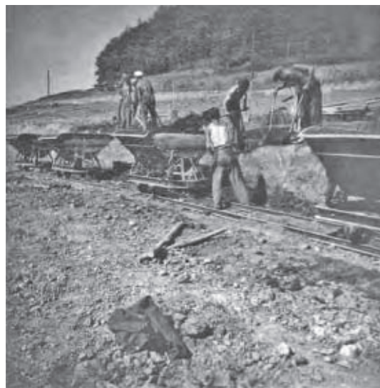
Dělníci firmy Hrabě & Lozovský v červnu 1941 na stavbě dálnice u obce Všechnovice
