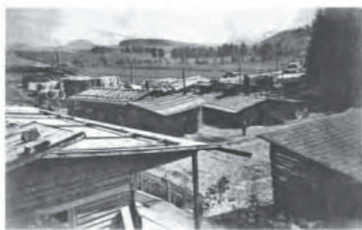
Celkový pohled na stavební dvůr firmy Hrabě & Lozovský pod Žernovníkem
