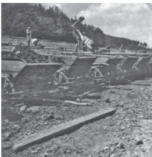
Dělníci firmy Hrabě & Lozovský v červnu 1941 na stavbě dálnice u obce Všechnovice
