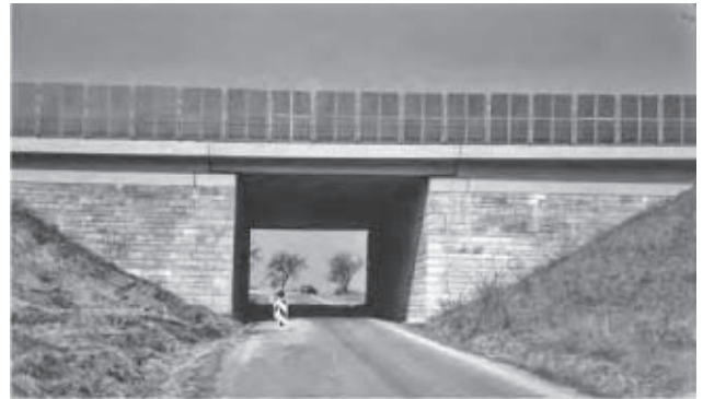
Most po rekonstrukci a dostavbě v roce 2004 v úseku využitém pro silnici R 52, (km 528,3)
