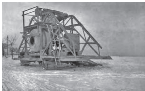
Míchačka na beton na staveništi mostu přes údolí Hlubockého potoka
