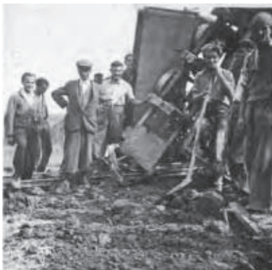
Nehoda stavební drážky na stavbě dálnice u obce Malhostovice
