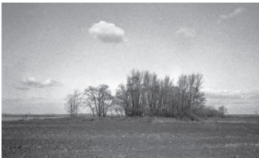
Jižní konec rozestavěného dálničního tělesa poblíž obce Ledce (1986), (km 529,7)
