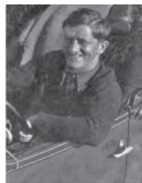
Hlavní účetní firmy Hrabě & Lozovský pan Jaroslav Šachl na stavbě dálnice
