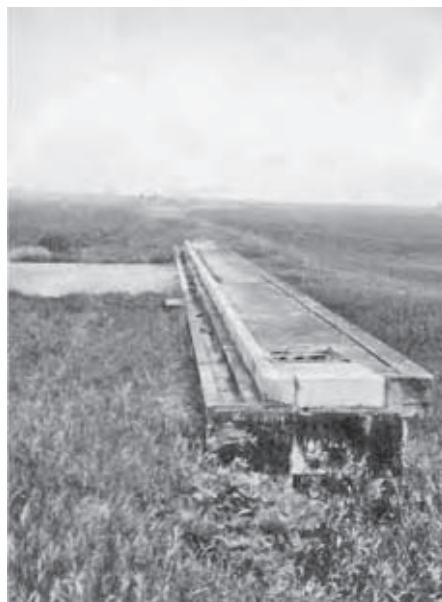
Detail římsy mostu (1962), (km 526,8)
