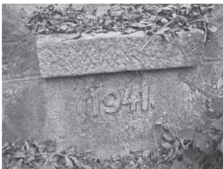
Detail označení roku výstavby trubního propustku u Žernovníka (km 486,5)
