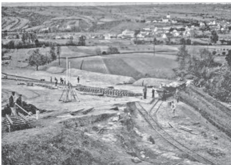
Stavba dálnice u obce Želešice v roce 1940
