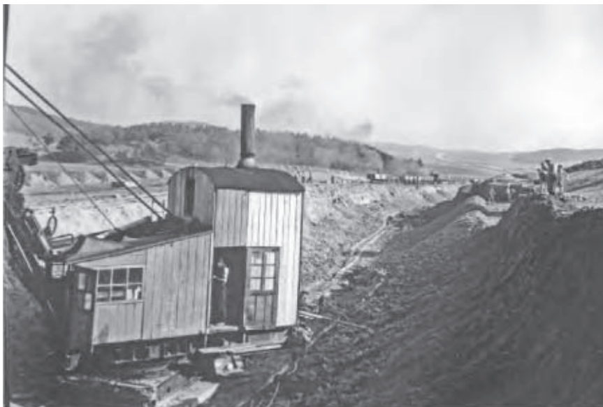
Jedno z parních rypadel typu Škoda (Lanna ev. číslo 6) při provádění zemních prací v zářezu dálnice mezi vrcholy kopců Převych a Cimperk západně od Kuřimi (4)
