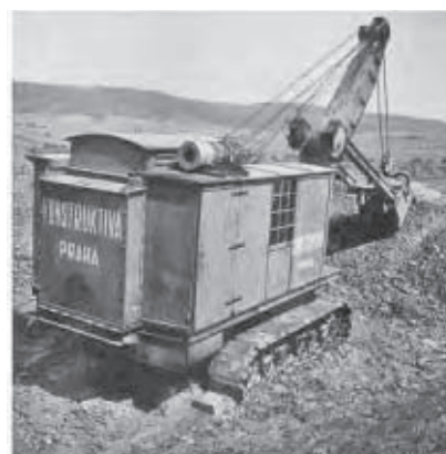
↑ ← Rypadlo Škoda typ D – 0.8 (při použití výškové lžíce)
