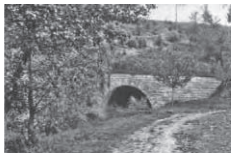
Celkový pohled na dálniční most přes Syrovický potok u Sobotovic (1962), (km 528,1)
