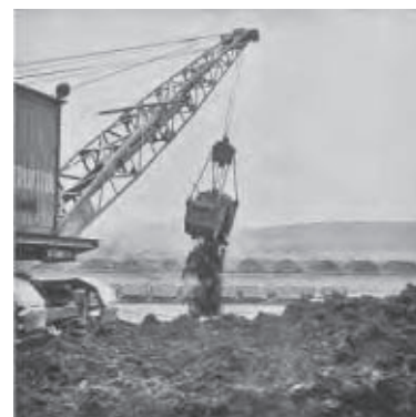
Rypadlo Škoda typ D – 0.8 (při použití drapáku)
