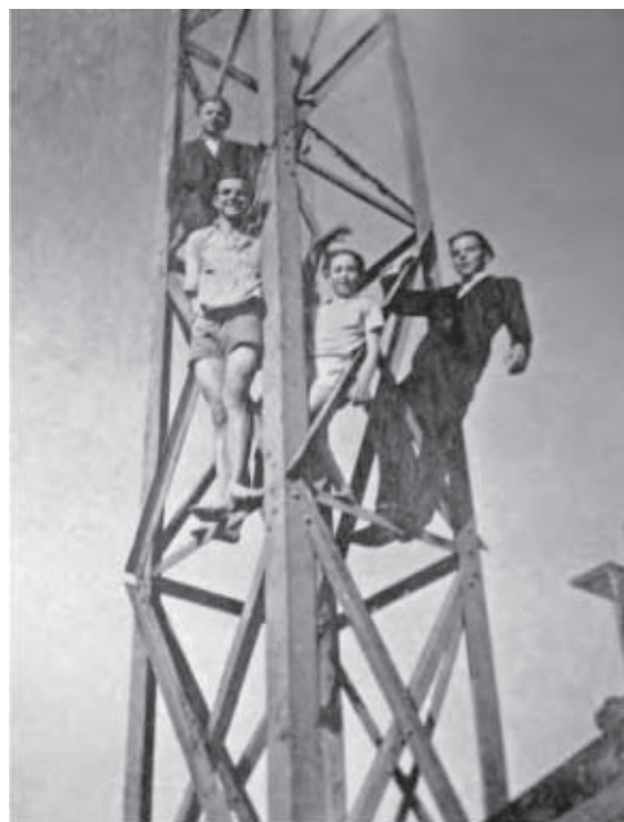
Konstrukce kabelového jeřábu se stala po zastavení stavebních prací vítaným cílem místní mládeže
