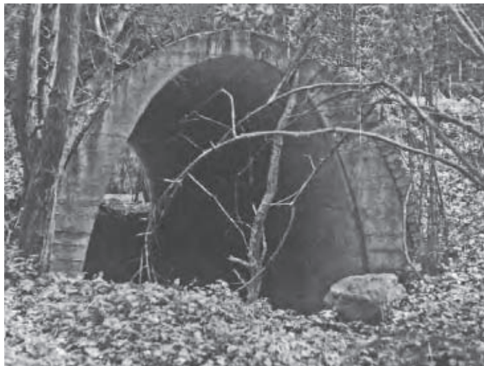
Nedokončený parabolický most u Žernovníka (km 486,1)
