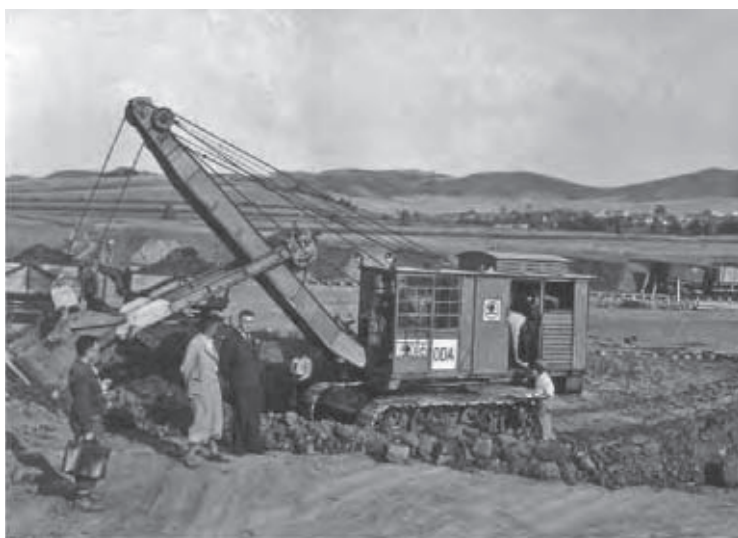
↑ ← Rypadlo Škoda typ D – 0.8 (při použití výškové lžíce)
