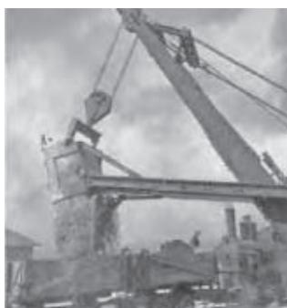
Detail lžice parního rypadla Škoda
