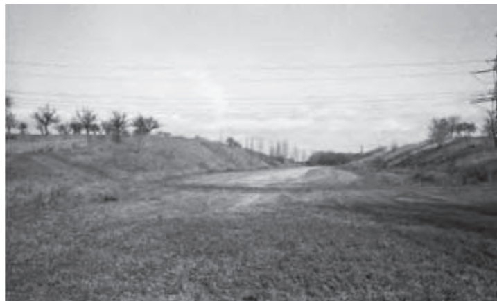
Zářez dálnice u obce Sobotovice (1986), (km 528,7 až 528,5)
