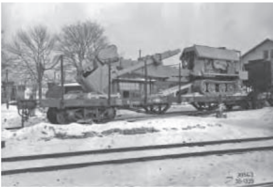
Rypadlo Menck – Škoda typ Mb 2 určené pro firmu Funke & Co připravené k transportu na stavenišťe dálnice po železnici
