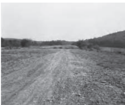
Těleso dálnice u Žebětína (1966), (km 505,7 až 510)
