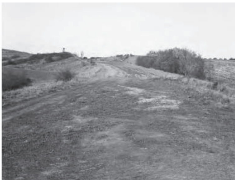
Kvalitně provedené zemní těleso dálnice u obce Rozdrojovice (1985), (km 505,8 až 505,2)
