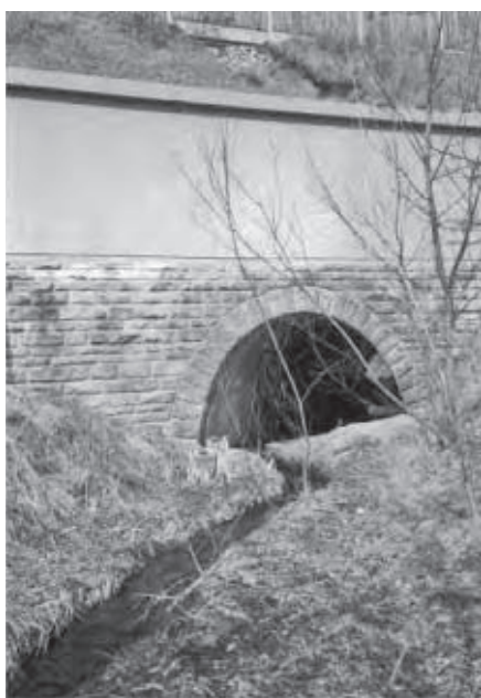
Úprava římsy původního dálničního mostu (2004) v úseku využitém pro silnici R 52, (km 528,1)
