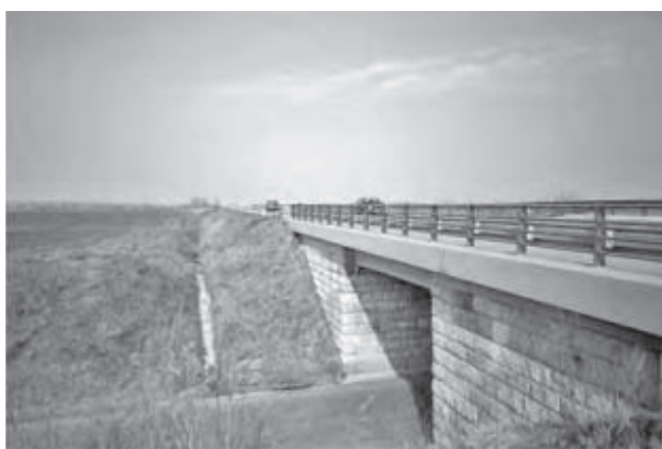
Dálniční most po rekonstrukci (2000) v úseku využitém pro silnici R 52, (km 526,8)
