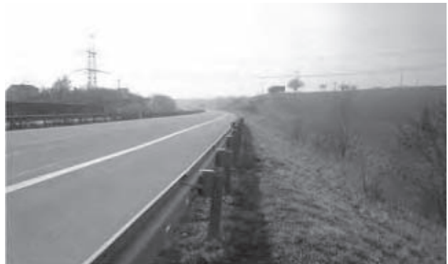
Zářez dálnice v roce 2004 v úseku využitém pro silnici R 52, (km 528,3 až 528,7)
