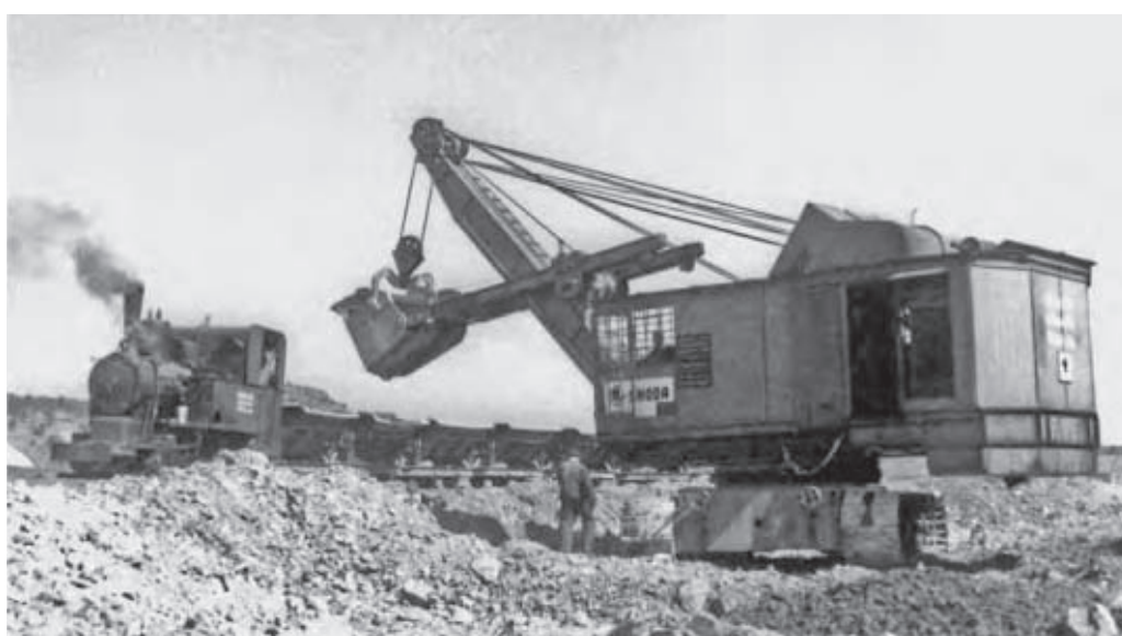
Motorové rypadlo Škoda a parní lokomotiva ČKD na stavbě dálnice u Želešic
