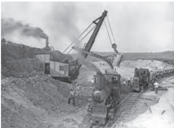
↕ Parní rypadlo Škoda (Lanna ev. číslo 5) a parní lokomotivy firmy Lanna na stavbě dálnice mezi Rozdrojovicemi a Kníničkami (8), (9)
