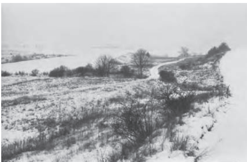
Pětiprocentní klesání do údolí místního potoka u obce Skalička (km 491 až 490,4)
