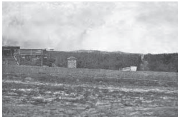
Staveniště mostu přes údolí Hlubockého potoka, v pozadí konstrukce kabelového jeřábu na severní straně údolí říčky Lubě (km 489,8 až 489,4)
