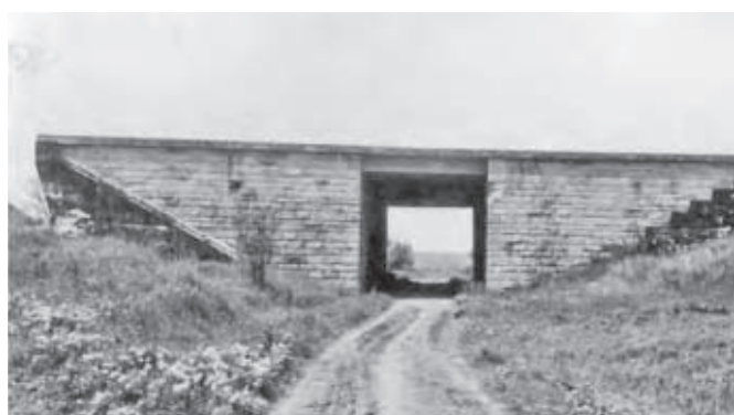
Celkový pohled na dálniční most přes polní cestu u Rajhradu (1962), (km 524,3)
