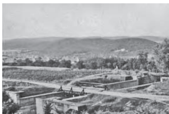
Nedokončený dálniční most přes polní cestu z Bystrce do Žebětína (1962), (km 508,6)
