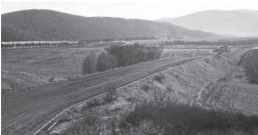
Kvalitně provedené zemní těleso dálnice u obce Rozdrojovice (1985), (km 505,2 až 506)
