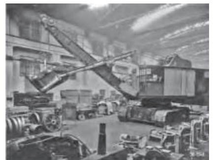
Téměř dokončené rypadlo Škoda typ D – 1.5 objednané firmou Funke & Co na stavbu dálnice
