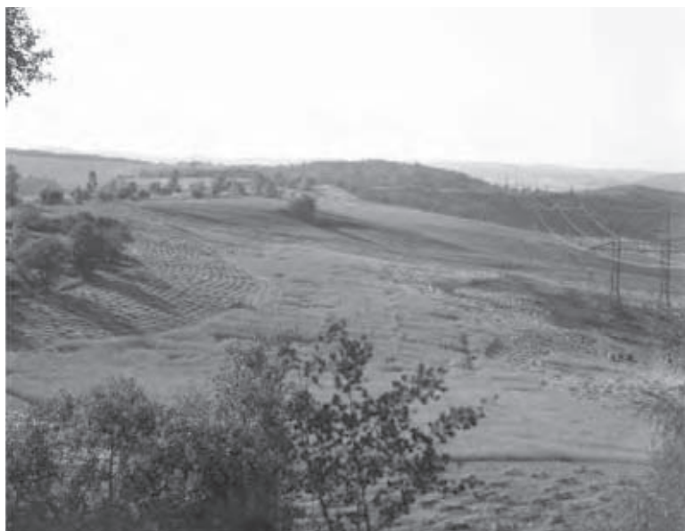
Částečně zemědělsky rekultivované zemní těleso rozestavěné dálnice na pláních u obce Nebovidy (1986), (km 518 až 517)
