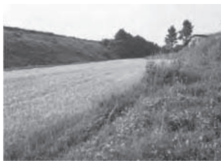
Těleso dálnice v Bystrci (1966), (km 508,8)
