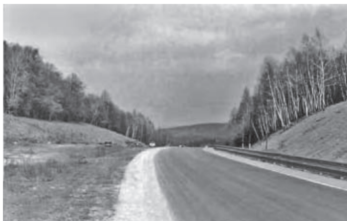
Těleso rozestavěné dálnice u Bosonoh využité na poloviční šířku při modernizaci závodní tratě Velké ceny ČSSR (dobový název) v druhé polovině šedesátých let 20. století (1979), (km 512)
