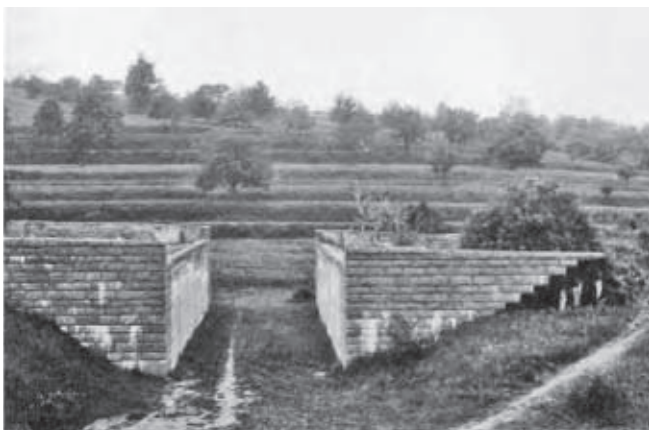
Nedokončený dálniční most přes polní cestu u Ostopovic (1962), (516)
