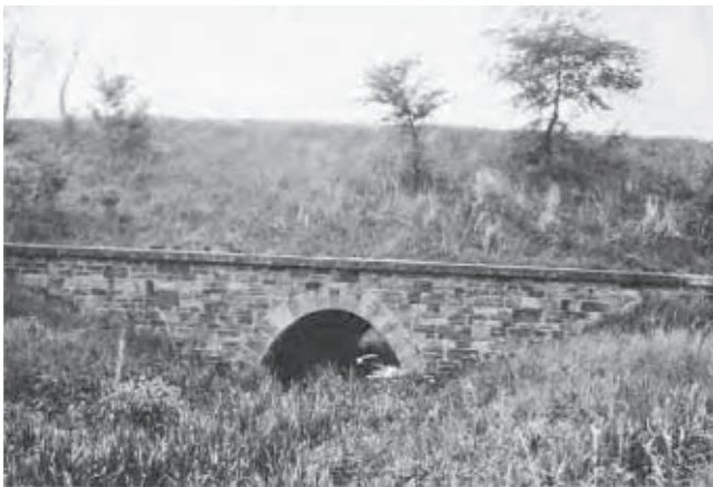
Dálniční most přes říčku Šatavu u obce Ledce (1962), (km 528,9)
