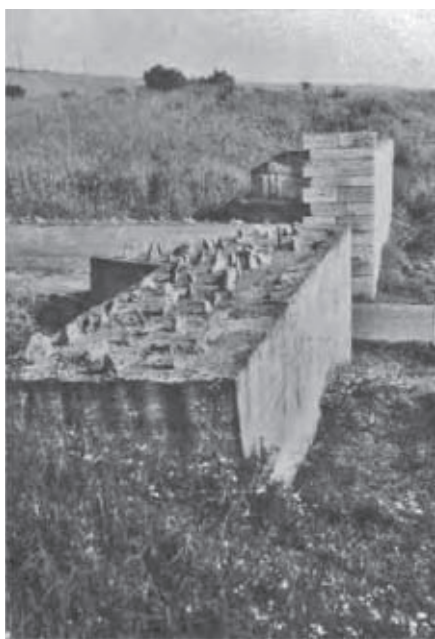
Detail rozestavěné opěry mostu u obce Rozdrojovice (1962)
