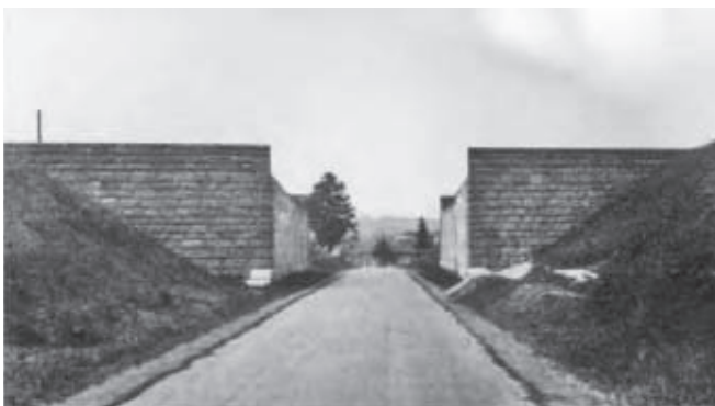
Nedokončený dálniční most přes silnici z Nebovid do Moravan (1962), (km 518,4)
