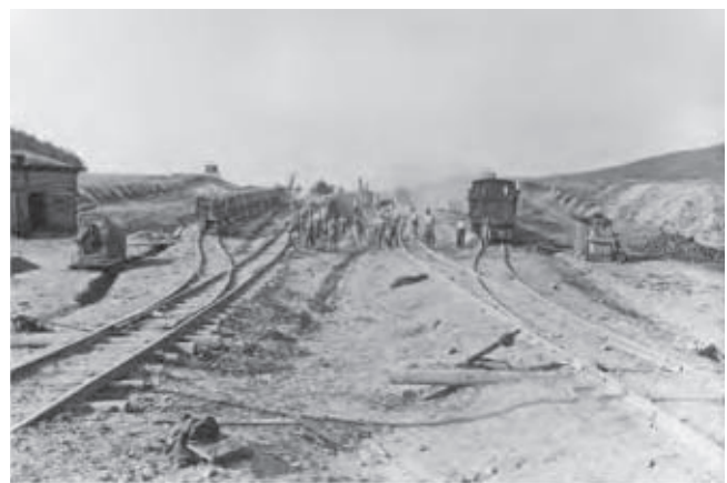
Hloubení zářezu mezi obcemi Jinačovice a Rozdrojovice (1)
