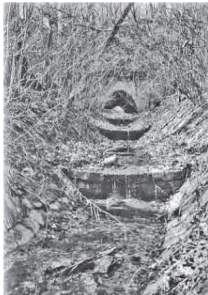
Dálniční most přes místní potok – detailní pohled na úpravu korytu (2004), (km 523,1)
