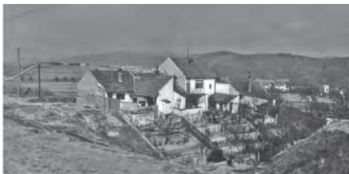
Průchod dálnice Bystrcí, v pozadí ubytovací tábor pro přespolní dělníky „Salzburg“ (březen 1941)
