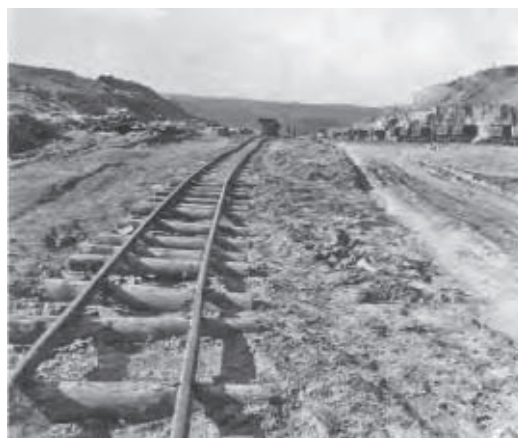
Zářez dálnice severně od Černé Hory
