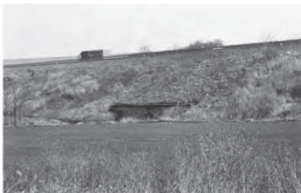
Celkový pohled na těleso dálnice a původní dálniční most (2004) v úseku využitém pro silnici R 52, (km 528,1)
