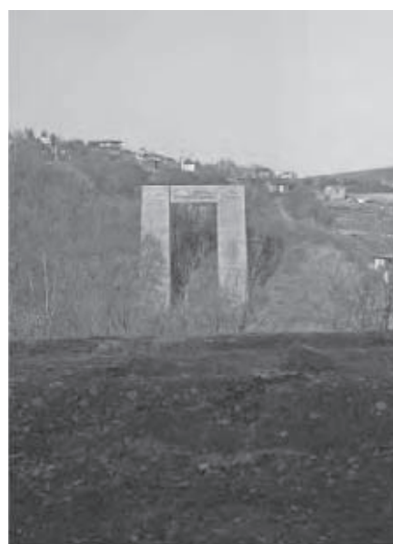
Pohled z rozestavěné jižní opěry na severní pilíř dálničního mostu přes údolí Svatky (1985), (km 507)
