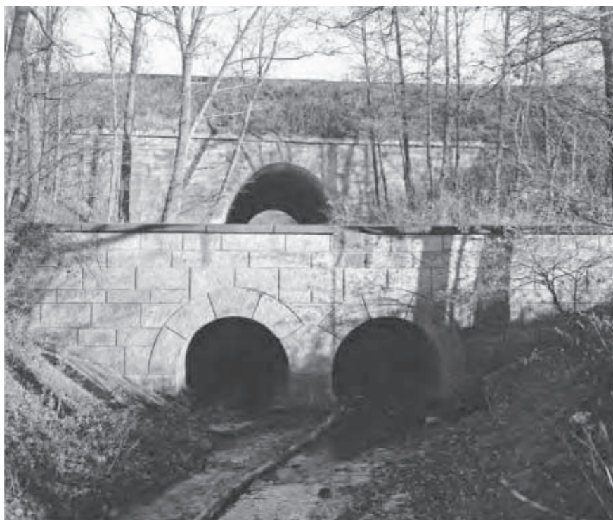
Dálniční most přes potok Vrbovec a polní cestu (1987), (km 509,3)
