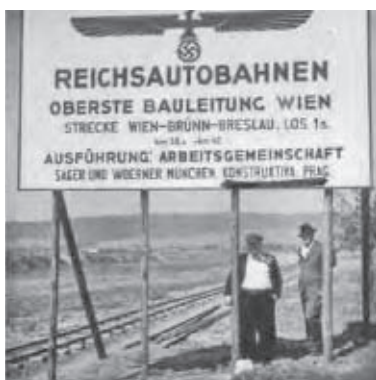
Sabotáž v očích stavbyvedoucího Gunsta – zdůraznění firmy Konstruktiva na informační tabuli
