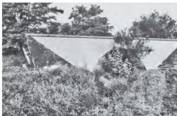
Celkový pohled na most přes říčku Kuřimku u Moravských Kniníc (1962), (km 499,9)
