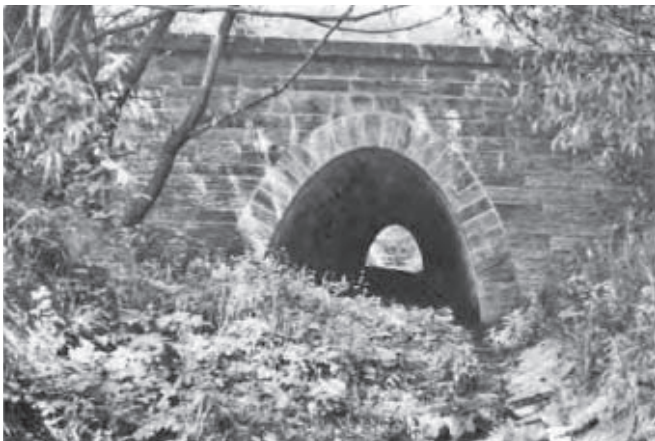
Dálniční most přes místní potok u Želešic – celkový pohled (1962), (km 523,1)
