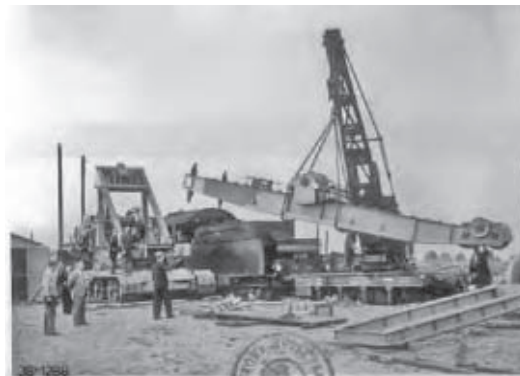
Montáž rypadla Škoda typ D – 1.5
