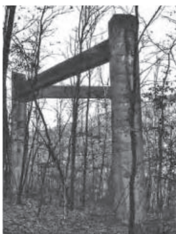
Konstrukce pro uchycení lana kabelového jeřábu (1985)
