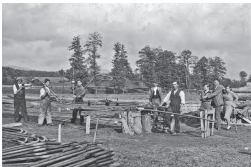
Příprava ocelové armatury pro stavbu mostu přes údolí Hlubockého potoka
