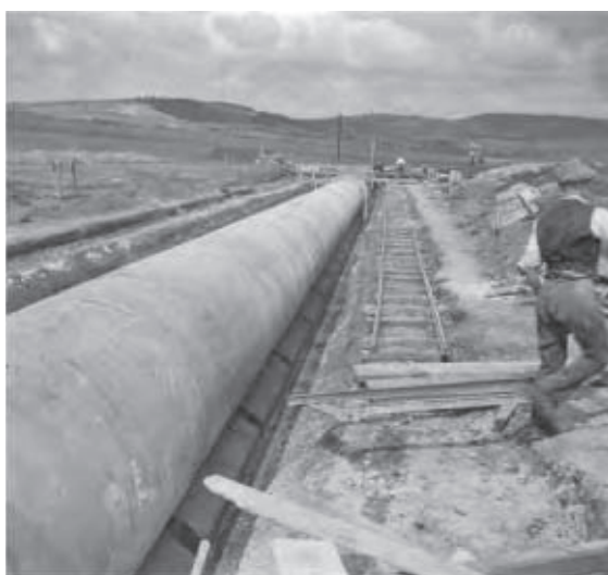
Stavba propustku na začátku stavebního dílu
