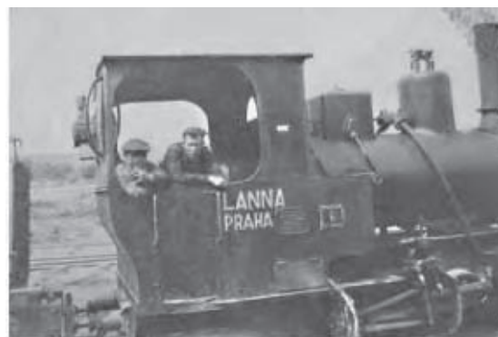
Parní lokomotiva firmy Lanna na stavbě dálnice mezi Kuřimí a Jinačovicemi
