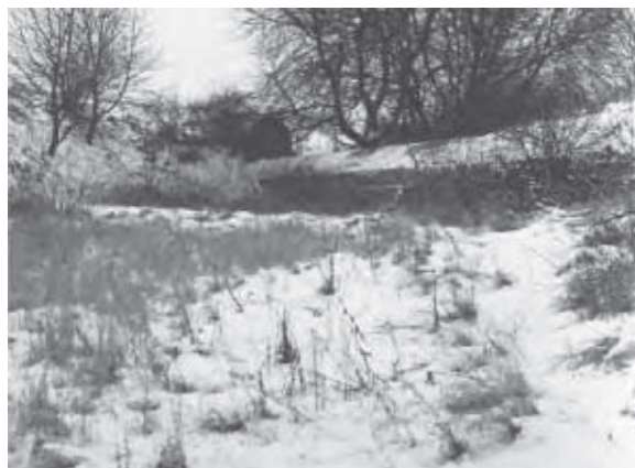
Stupňovitý propustek u Malé Lhoty (km 488,2)
