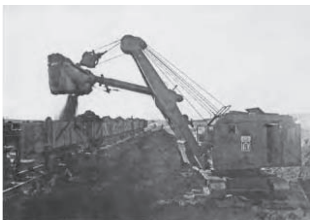
Motorové rypadlo Demag typ K 22 firmy Pittel & Brausewetter na stavbě dálnice u Rozdrojovic (6)
