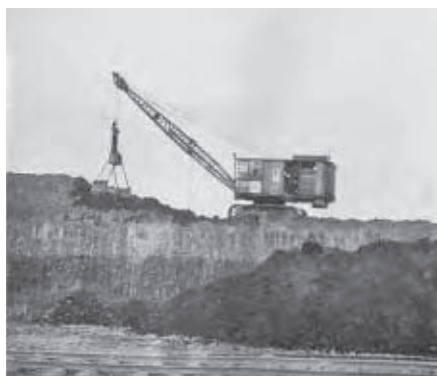
Rypadlo Škoda typ D – 0.8 (při použití drapáku)
