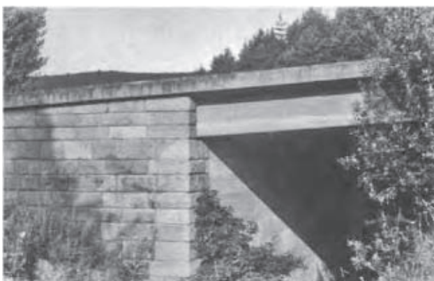
Dálniční most přes polní cestu u Žebětína (1962), (km 509,7)
