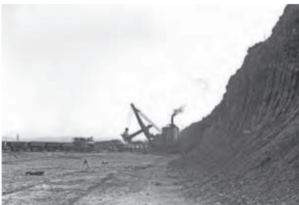
↕ Parní rypadlo Škoda (Lanna ev. číslo 5) a parní lokomotivy firmy Lanna na stavbě dálnice mezi Rozdrojovicemi a Kníničkami (8), (9)
