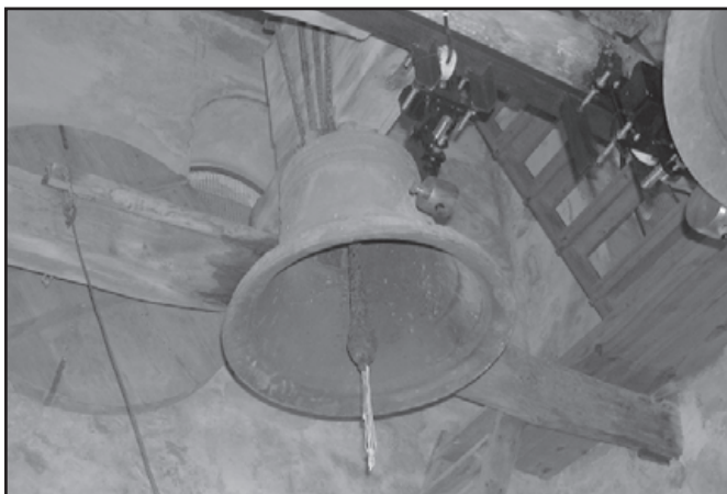
El nou sistema de martells deixa lliure els batalls per poder ser accionats manualment.
