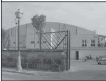
Entrada a l'aparcament del Poliesportiu
