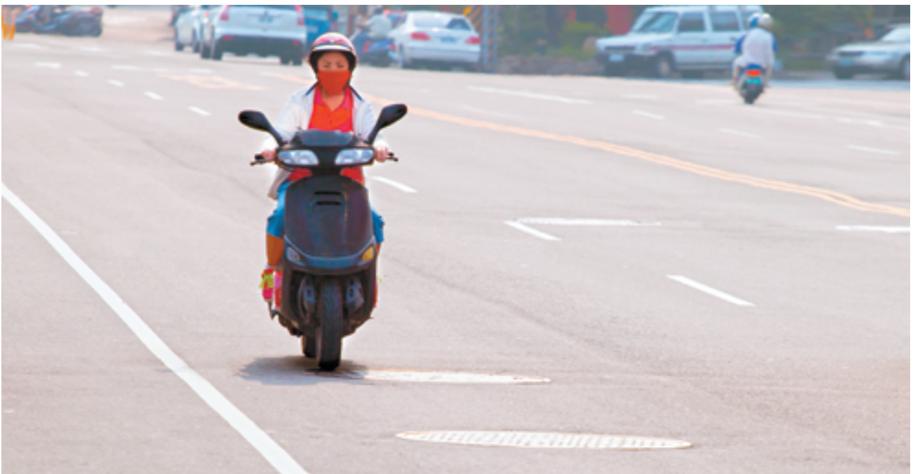
道路上凸起的孔蓋經常是機車族的殺手，因此路平計畫要讓孔蓋下地或與路面齊平。
